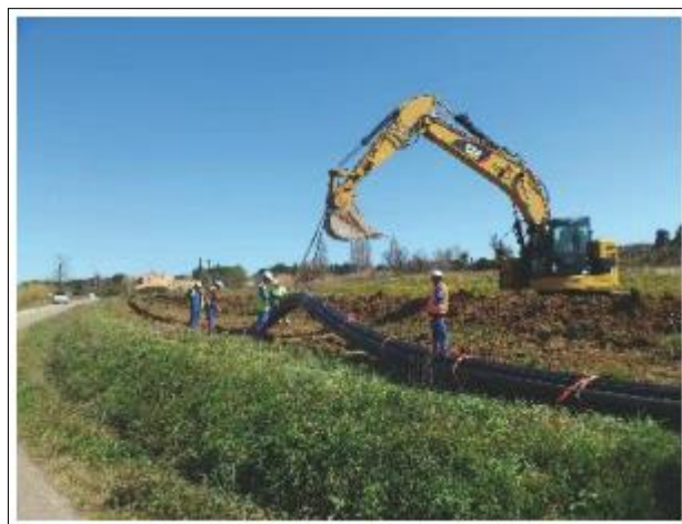
Figure 6 : Photographie de pose des fourreaux PEHD en plein terre
