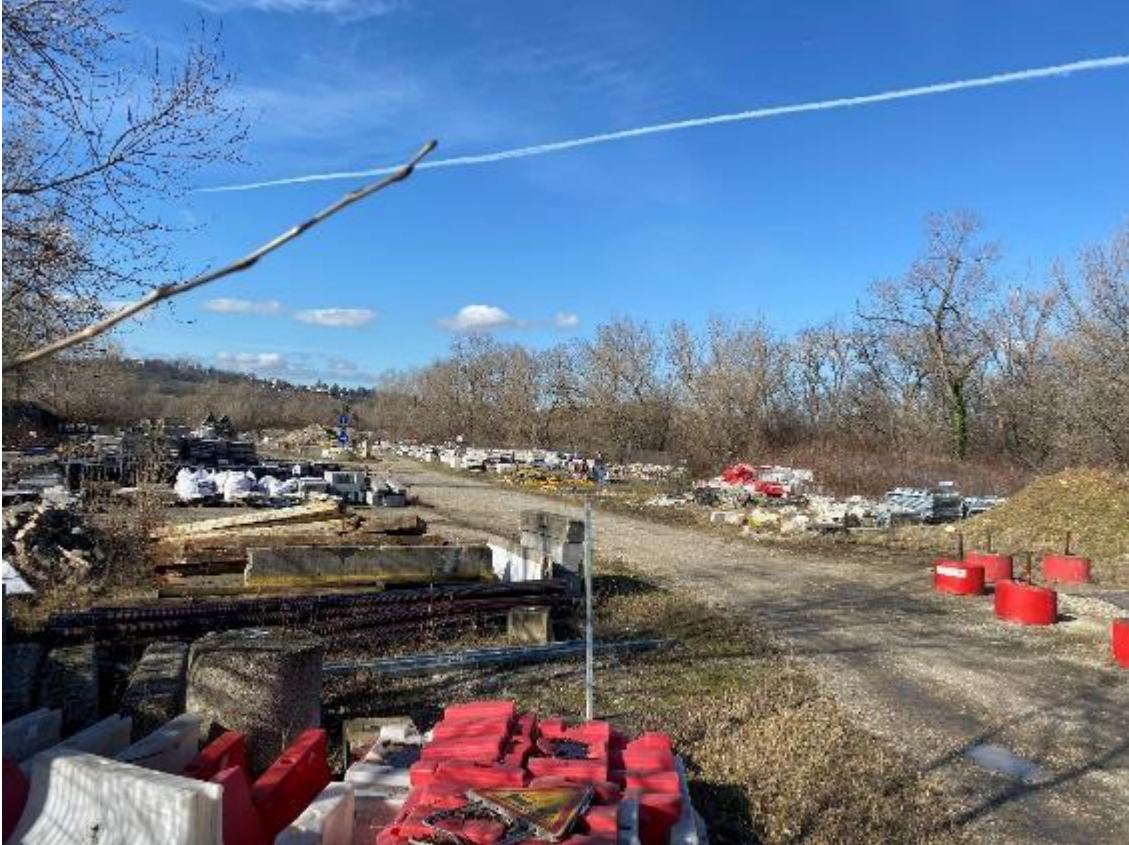
Vue n°1 – Terrain d'implantation du poste RHÔNA à Feyzin
