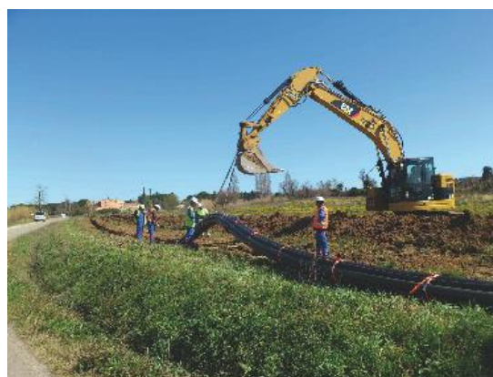
Pose des fourreaux PEHD en pleine terre
