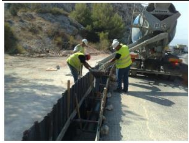
Figure 5 : Photographie de coulage du béton
