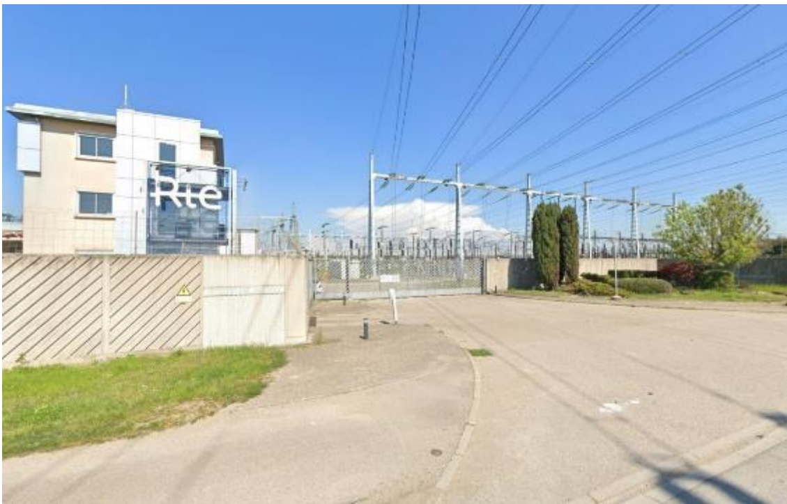
Vue n°8 – Entrée du poste électrique de MIONS
