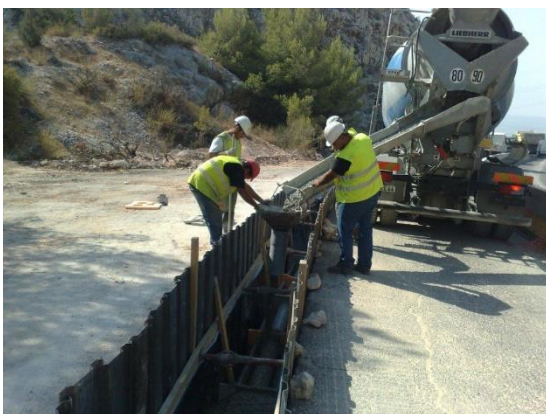
Coulage du béton
