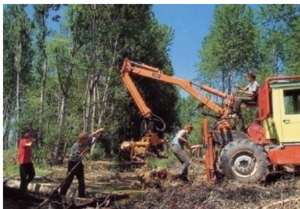
Figure 8 : Photographie d'une intervention de gestion d'embâcles
