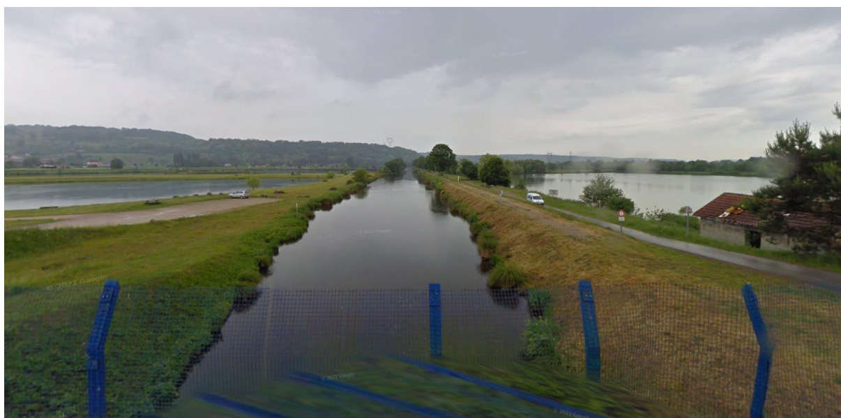
6 : Point de vue depuis l'écluse 33 de Socourt (mai 2011)
