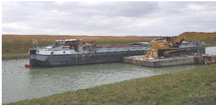
Figure 4 : Illustration d'un dragage mécanique d'une pelle sur ponton (source : VNF)
