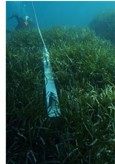
Illustration 38: Ancrage à 3 vis en Posidonie (ZMEL de Bagaud, 2020)
