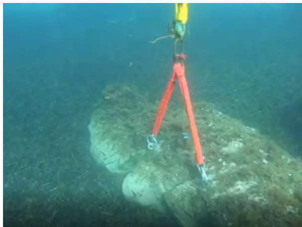
Illustration 41: Exemple d'ancrage sur bloc rocheux (ZMEL de Bagaud, 2020)
