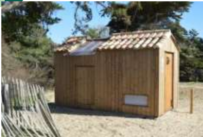
Modèle toilettes sèches à Lombricompostage, couverture tuiles tiges de botte et bardage bois vertical
