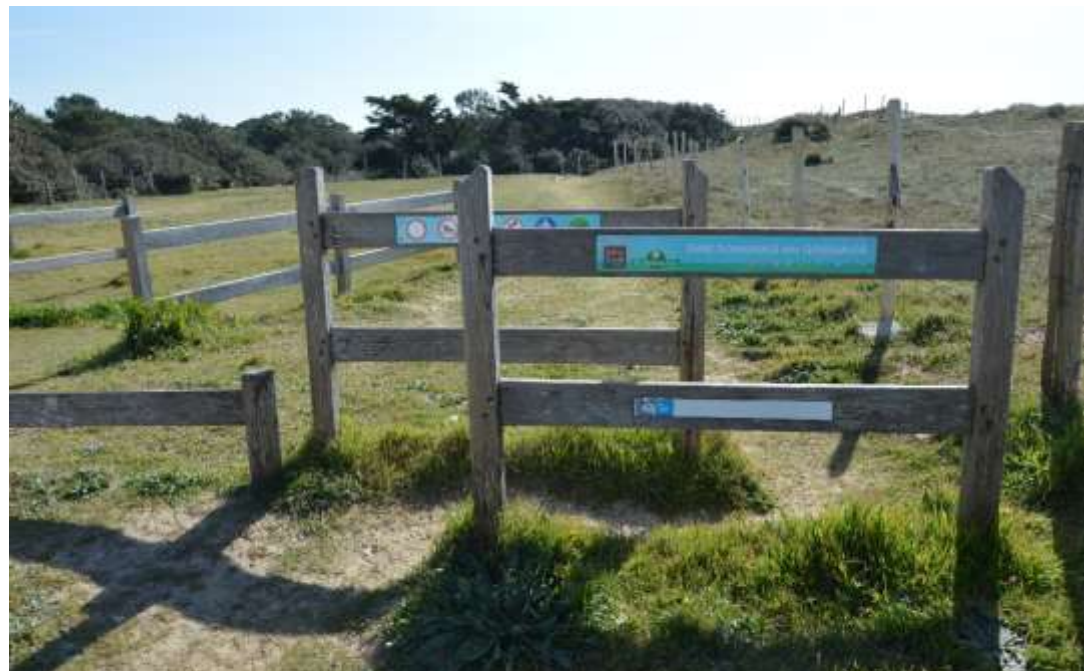
A l'est du parking, présence de chicanes bois donnant accès au sentier littoral + lices vélo sur la gauche : à supprimer
