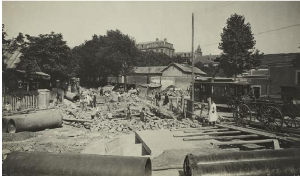
Figure 63 : 1904 - Construction du Chemin de Fer Métropolitain Municipal de Paris - Rues Belgrand et Pelleport - Chantier de raccordement avec les Ateliers de la Compagnie, vers la Place Gambetta [Collection RATP, 3N103A]
