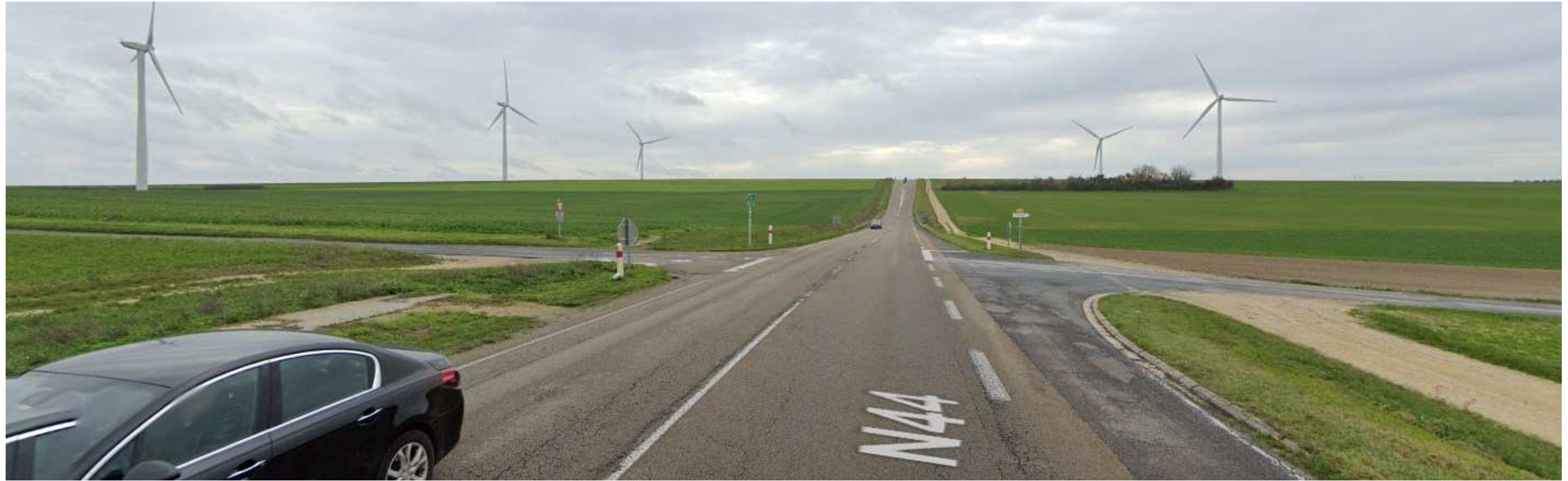
Photo n°1 – novembre 2022 – Vue depuis la RN44 vers Vitry-le-François sur le carrefour actuel avec la RD402 (fermeture des accès)
