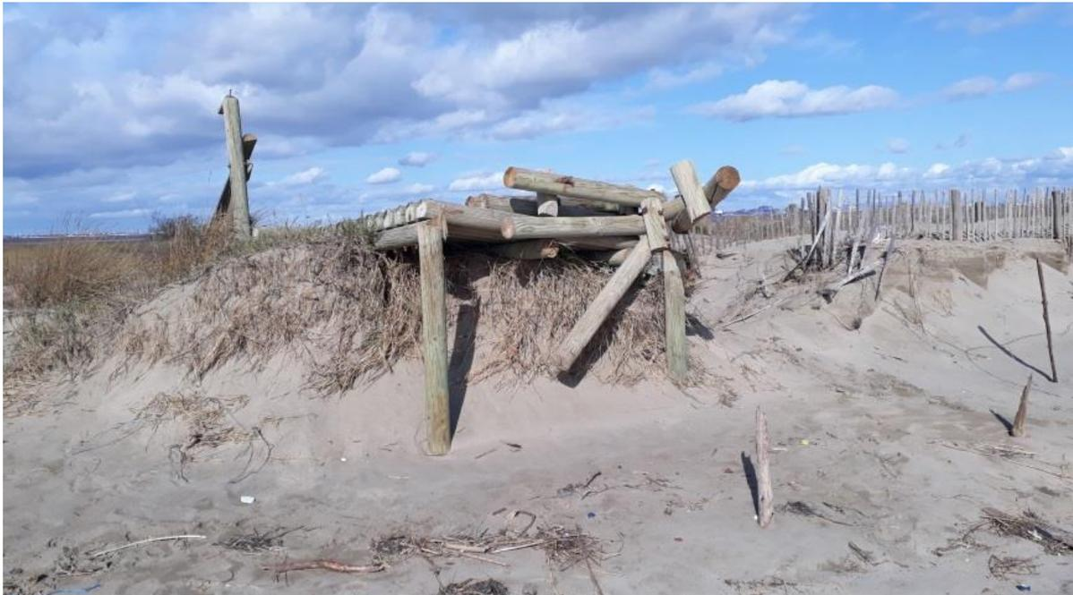
Figure 4 l'escalier ouest, du moins ce qu'il en reste ; la descente a été emportée, la structure est en voie de démantèlement et ne pourra pas rester en l'état (EID, 2019).
