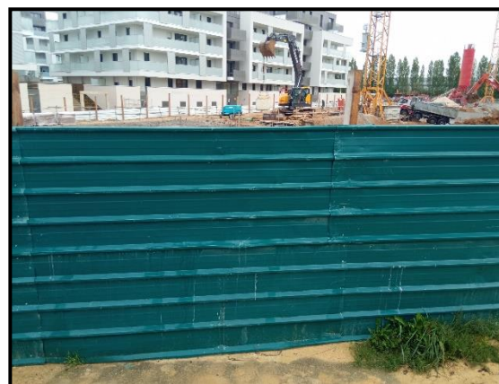
Photo 15 : Zones de travaux (Rainette, 2021)
