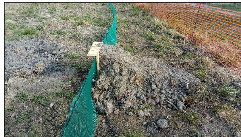
Photo 34 : Barrière à amphibiens et échappatoire (Rainette)
