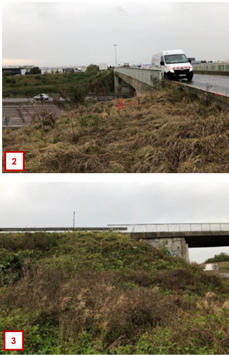
Figure 4 : Prises de vues rapprochées du site du projet Source : Etude géotechnique G2 AVP, Hydrogéotechnique, 28 janvier 2022
