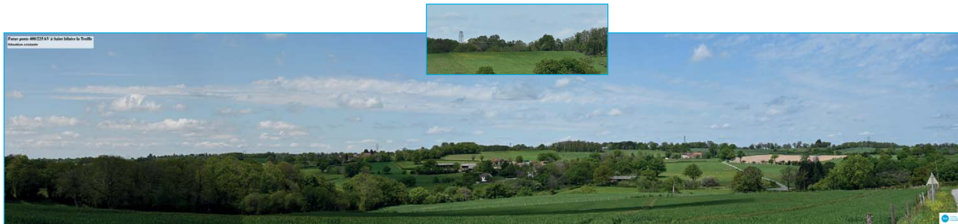
Vue générale (3) du raccordement : situation actuelle avec zoom sur le pylône n°104
