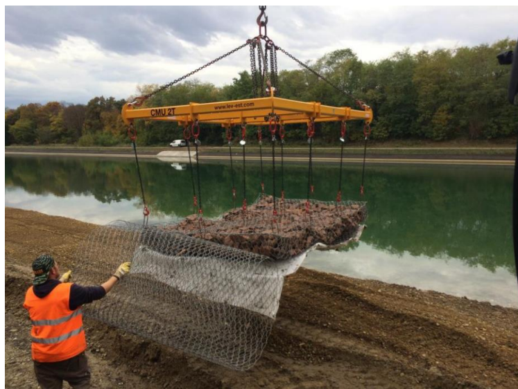
Figure 3 : Grutage du matelas après remplissage en berge (source : DLE, VNF 2021)
