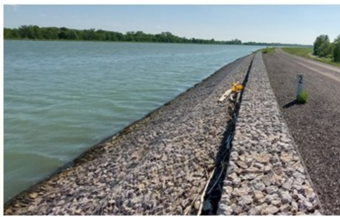
2. Tronçon de berge restauré
