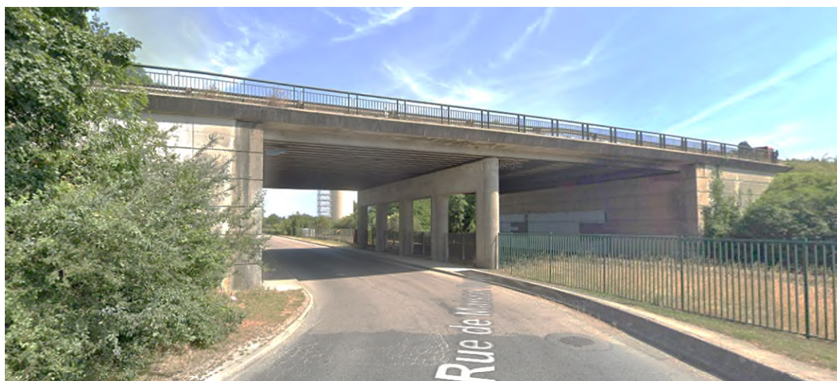
Figure 18 – Image de la structure (avant électrification des voies)
