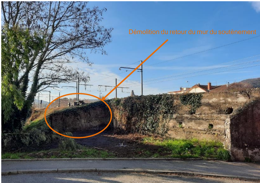
Figure 4 - Photo depuis la sortie du tunnel rue du 11 novembre, côté Est, en direction du Sud
