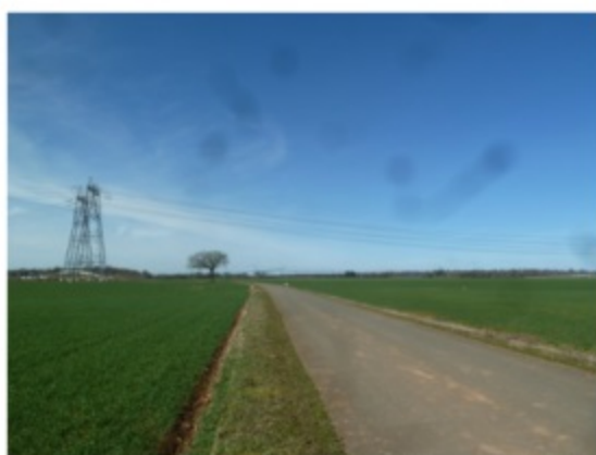
Photo 6 : Chemin rural desservant le poste de ROM.
