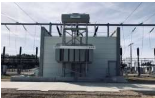
Figure 2 : Exemple d'une self à huile dans une enceinte fermée (à gauche) et d'un transformateur 225 kV (à droite)
