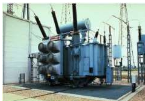
Figure 2 : Exemple d'une self à huile dans une enceinte fermée (à gauche) et d'un transformateur 225 kV (à droite)
