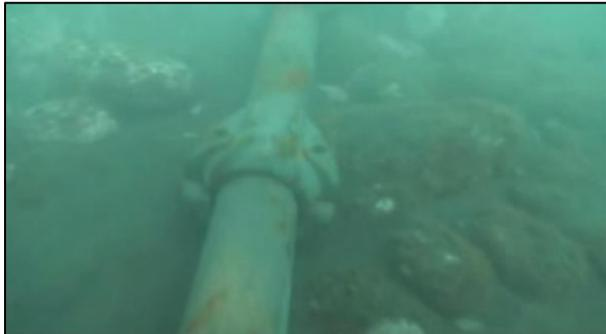
Exemple de coquilles en fonte sur le câble (Câble SAFE, La Réunion, d'ORANGE)
