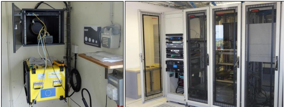
*Exemple d'aménagement de poste côtier (observatoire EMSO-Nice) : alimentation électrique et connexions avec la partie sous-marine (à gauche) et équipements informatiques (à droite) – local de 60m<sup>2</sup>*
