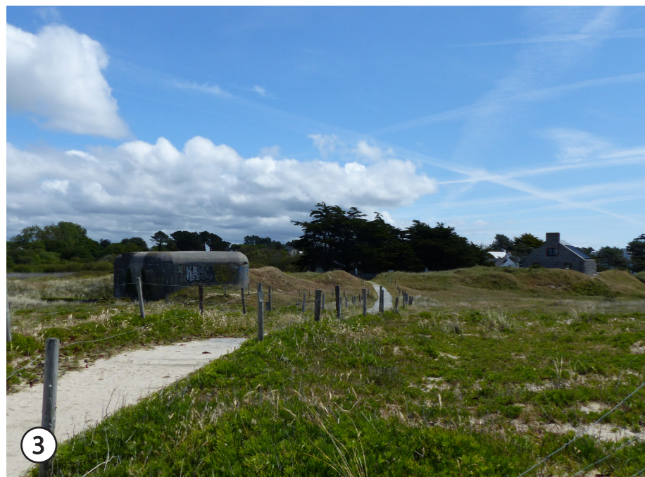
3 Vue du blockhaus
