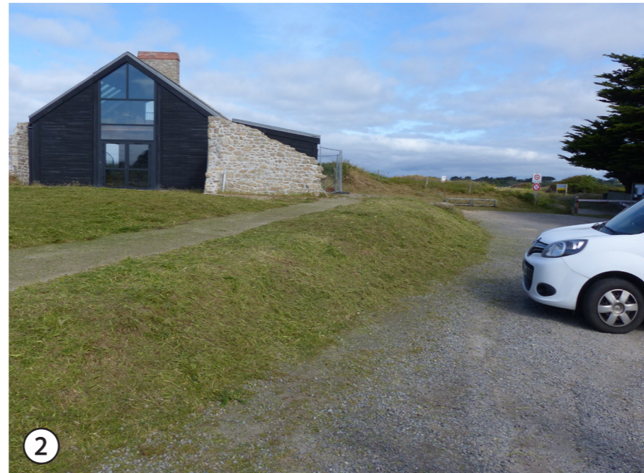
2 Accès à la Maison du Littoral et au site de Kerouiny
