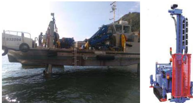
Figure 2 : Matériel mis en œuvre pour le sondage pressiométrique
