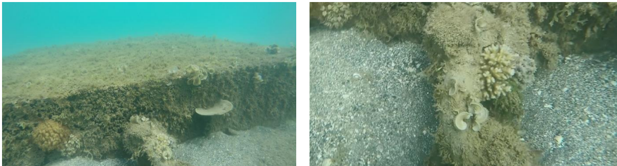
Figure 29 : Colonisation des corps morts et chaînes du ponton flottant.
