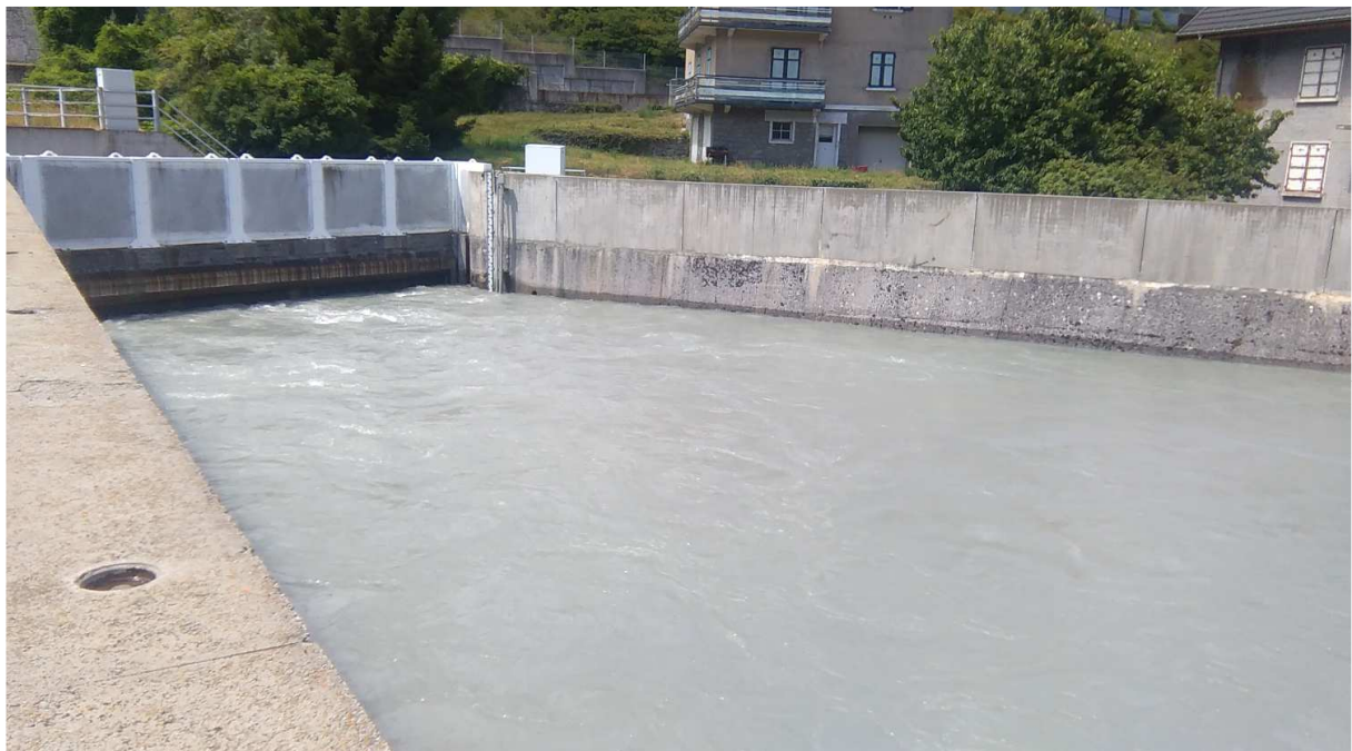
Photo 3 : Restitution des eaux de la centrale à l'Arc (07/2018)
