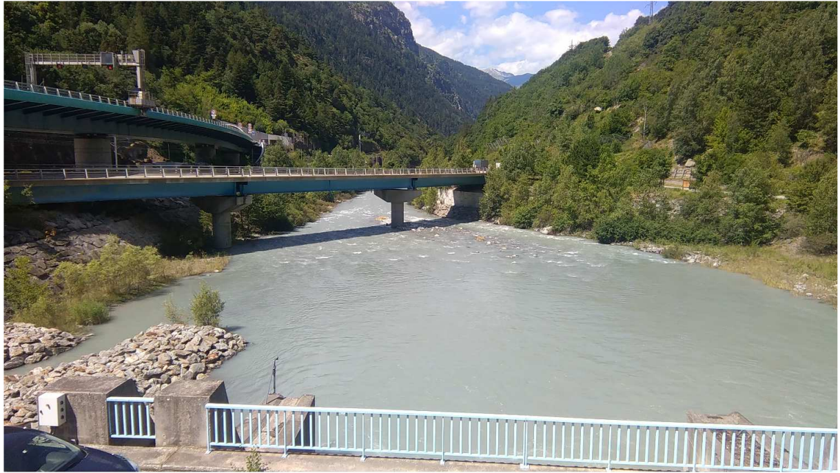
Photo 6 : Aval du barrage de Pont-des-Chèvres, vu depuis le couronnement du barrage (07/2018)
