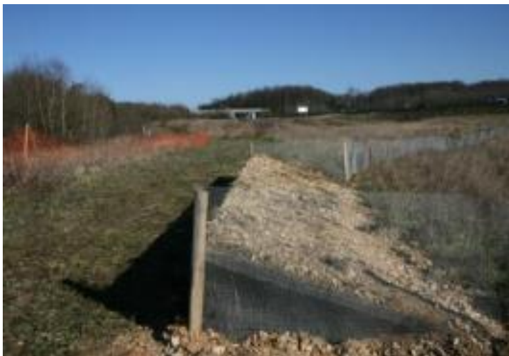
Exemple de barrière à amphibiens avec échappatoire
