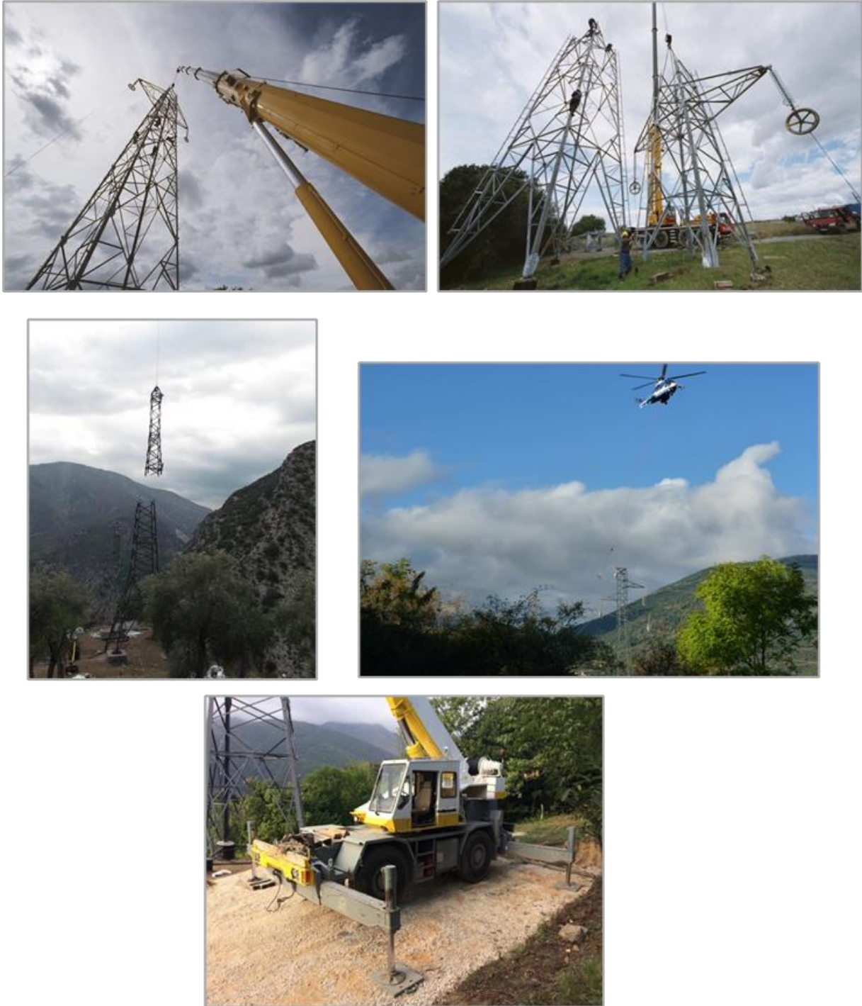
Figure 11 | Photographies de la mise en place des pylônes
