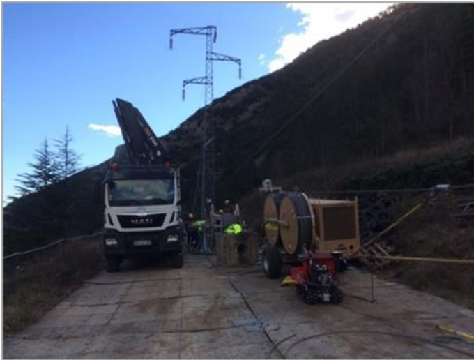
Figure 10 | Photographie d'une plateforme de déroulage
