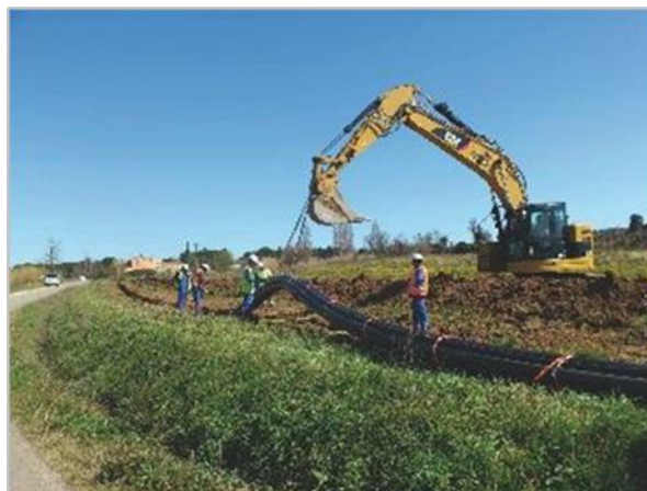
Figure 16 | Pose des fourreaux PEHD en pleine terre
