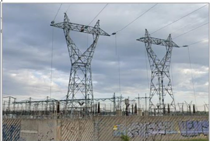
Figure 6 | Photographies de supports 400 000 volts (à gauche) et 225 000 volts (à droite)
