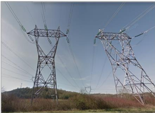
Figure 6 | Photographies de supports 400 000 volts (à gauche) et 225 000 volts (à droite)
