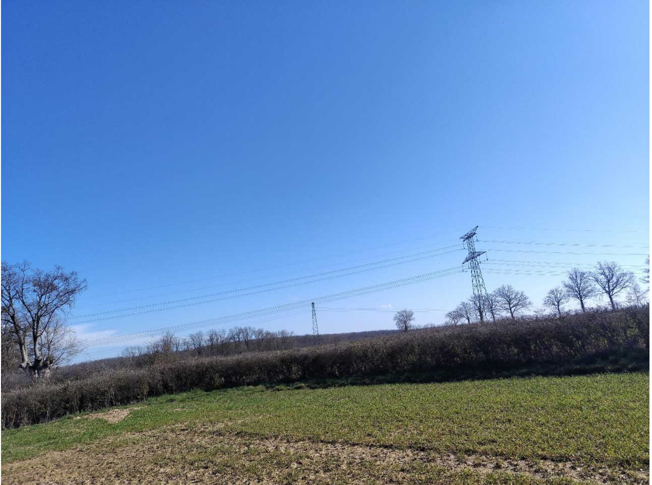
Photographie 6 | Aperçu de la zone d'implantation du poste électrique au Nord-Ouest - Vue vers l'Est (ING'EUROP, 03/03/2026)
