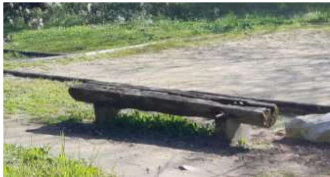
Bancs existants autour du terrain de boule en très mauvais état à remplacer par ...
