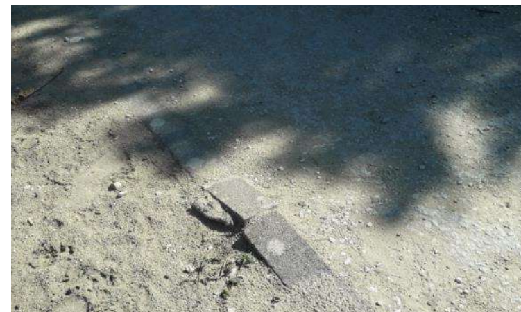
Sentier en calcaire stabilisé existant de 1,5m de large bordé de pavés. Certaines zones présentent des pavés qui se déchaussent.
