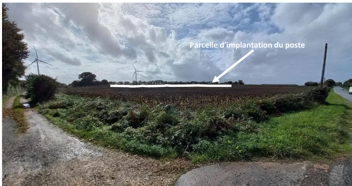
Figure 13 – vue lointaine de la parcelle d'implantation du poste de transformation électrique
