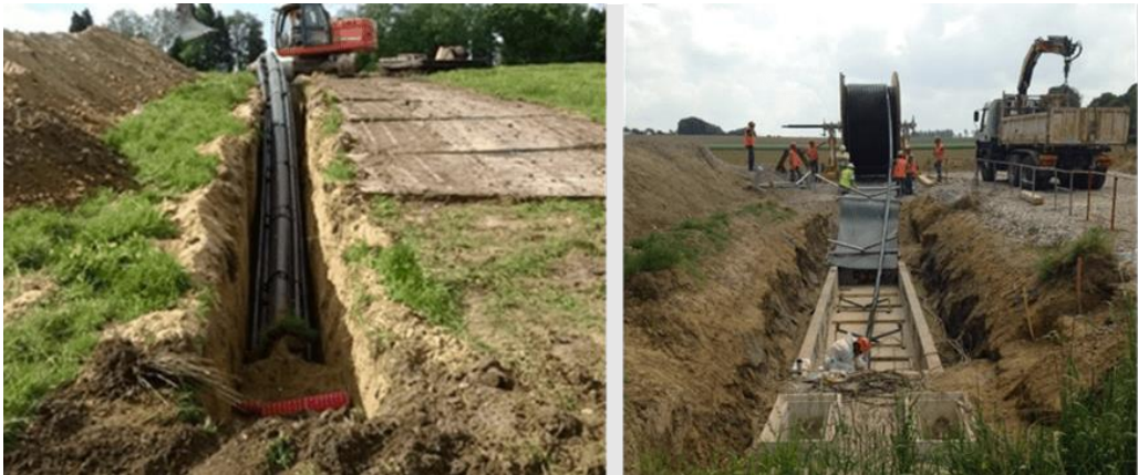
Figure 14 : Pose de fourreaux (à gauche) et exemple de déroulage (à droite)
