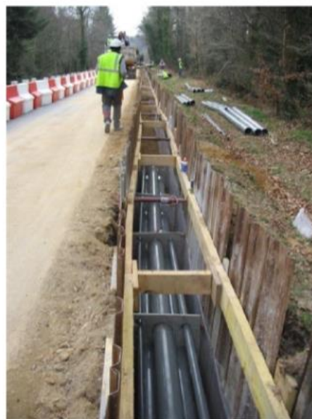
Figure 7 : Vue en coupe de la pose en fourreaux PVC
