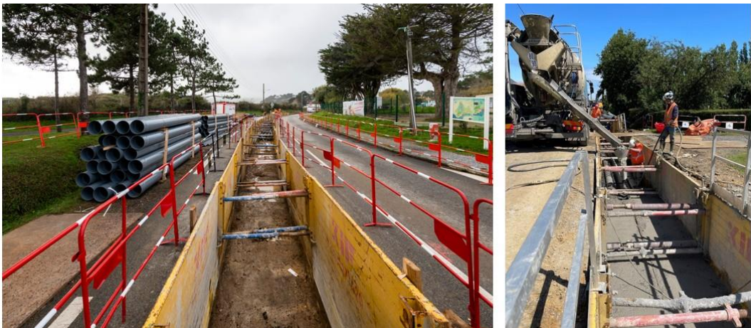
Figure 15 : Pose de fourreaux PVC (à gauche) et coulage béton (à droite)
