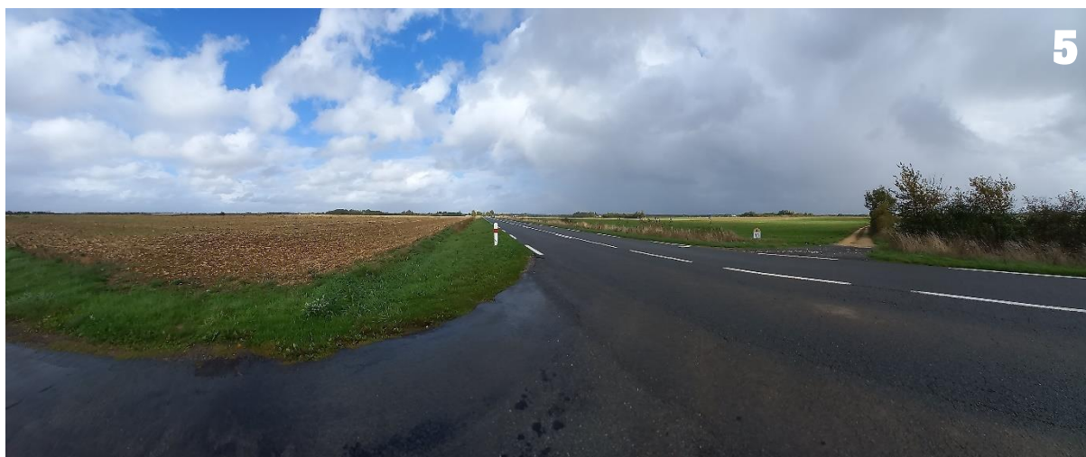
Figure 17 - La liaison souterraine traversant des voiries et des parcelles agricoles
