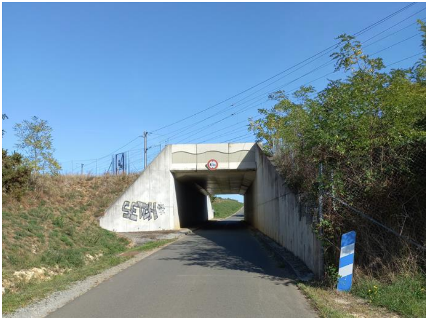
Figure 17 : Exemple de pont-rail présent dans l'aire d'étude
