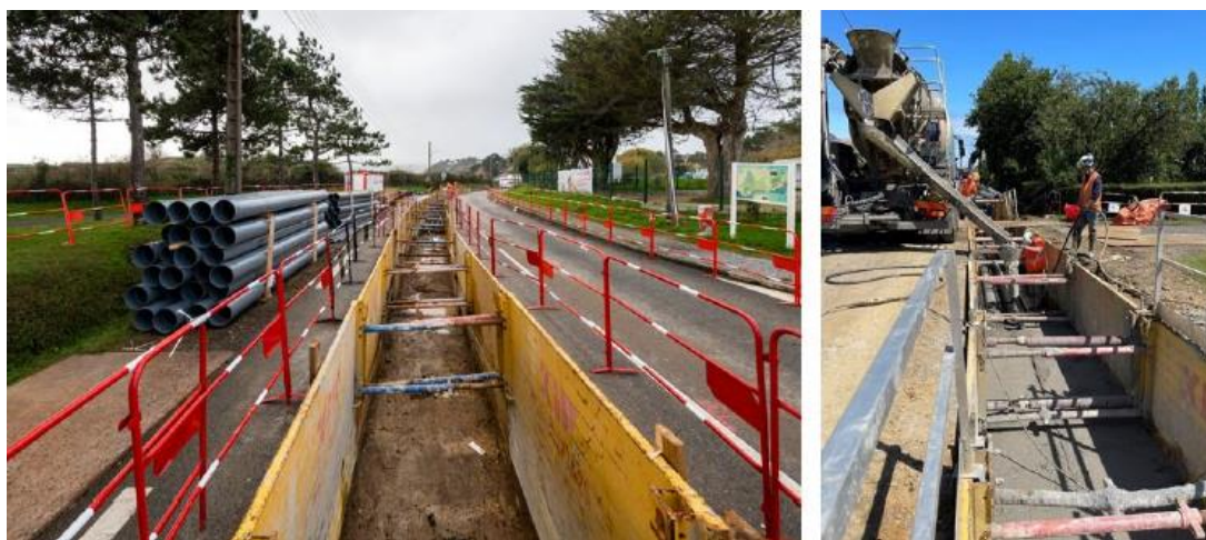
Figure 5 - Pose de fourreaux PVC (à gauche) et coulage béton (à droite)
