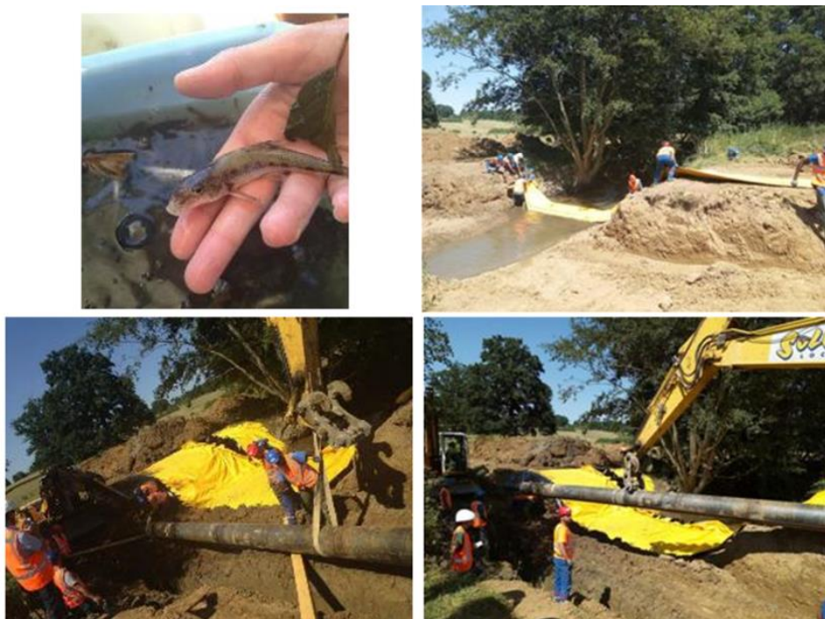
Figure 13 : Exemple d'un ensouillage par barrage mobile
