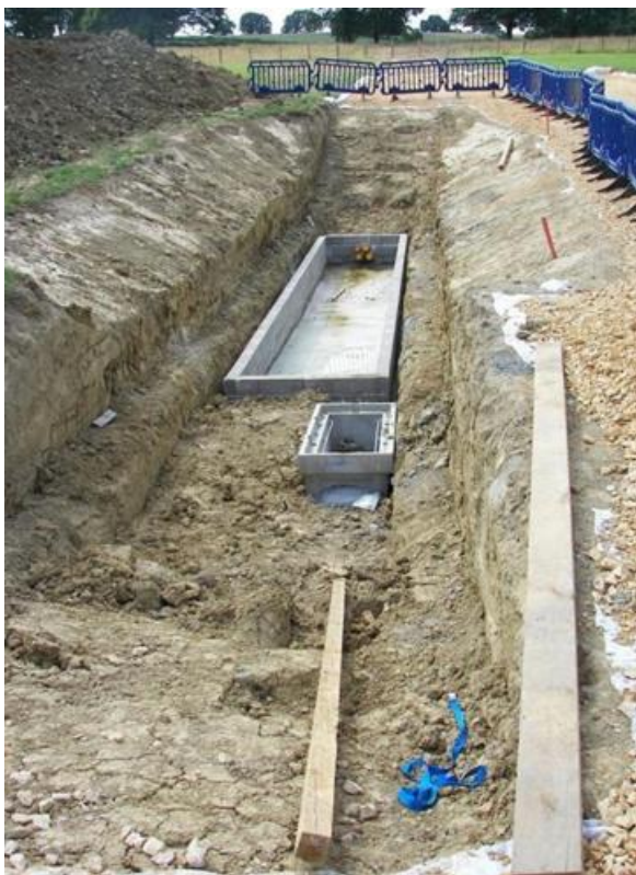
Figure 9 : Photographie d'une chambre de jonction en phase travaux
