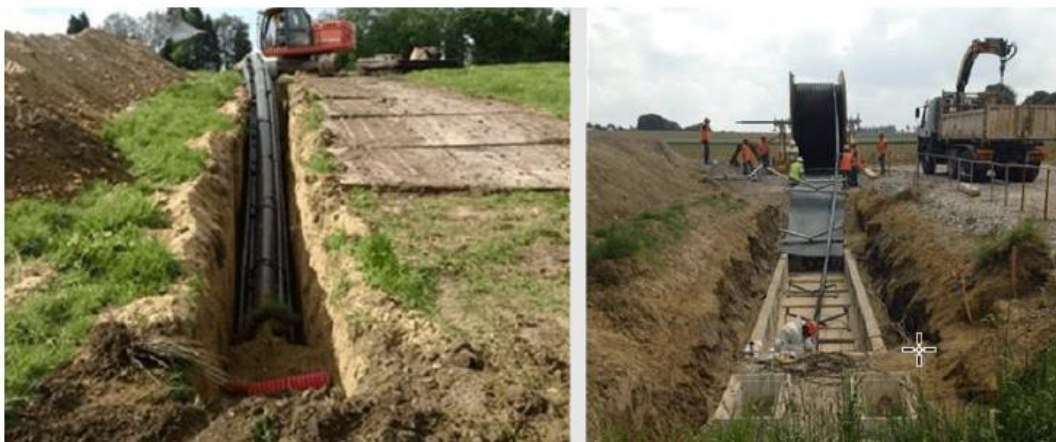
Figure 4 - Pose de fourreaux (à gauche) et exemple de déroulage (à droite)
