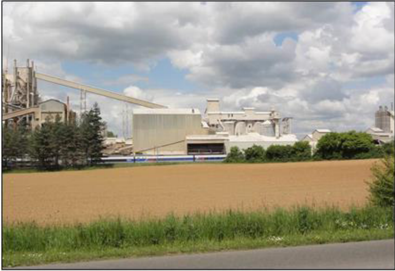
Figure 46. Installations de LHOIST France à Neau
