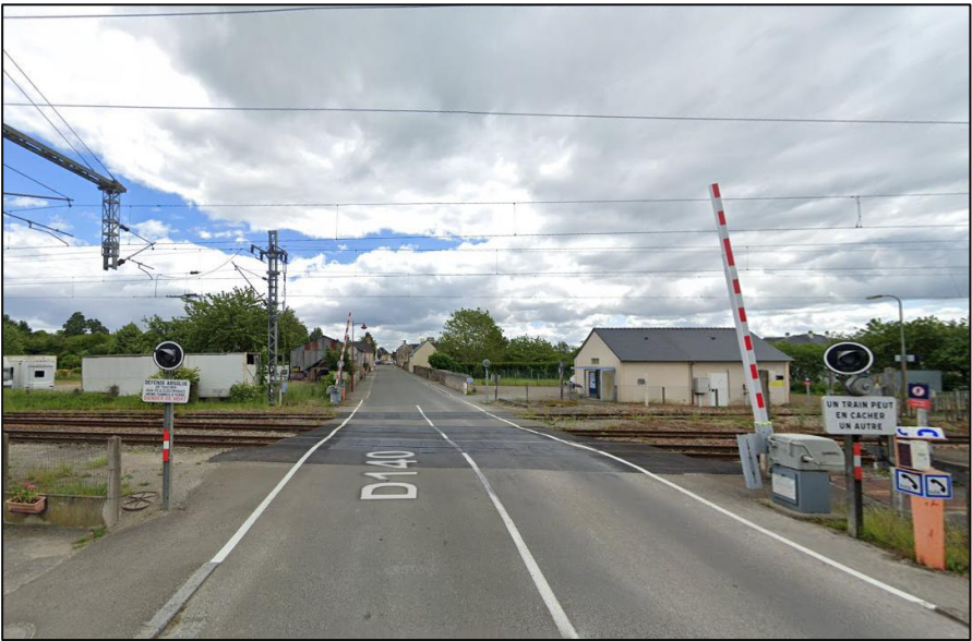
Figure 45. Localisation du passage à niveau n°145 à Neau (53). Source : Google Maps
