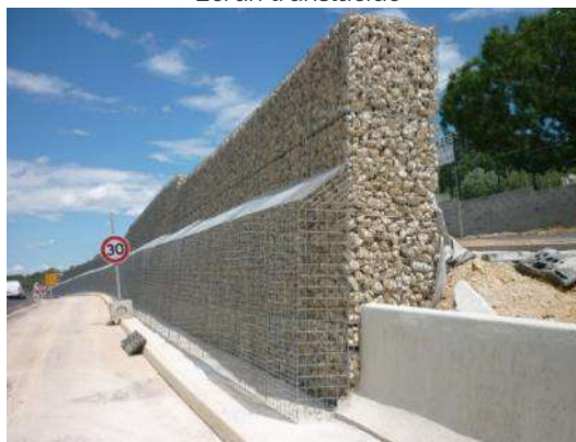
Ecran en gabions
