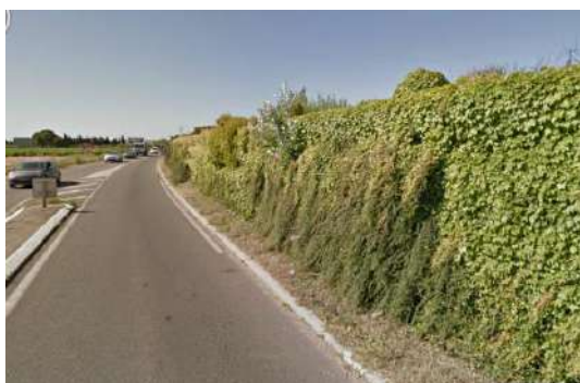
Ecran végétalisé avec mur béton
