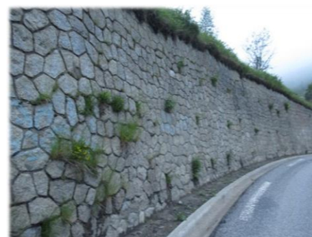
Mur en pierre présentant des cavités favorables aux espèces fissuricoles
