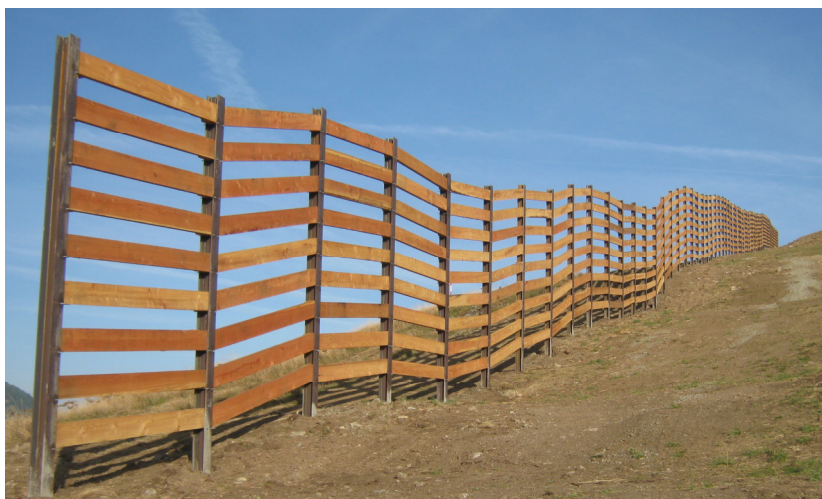
Figure 10: exemple d'un dispositif de barrières à vent posé dans une pente discontinue (col du Lautaret pour le conseil départemental des Hautes Alpes – RTM).
