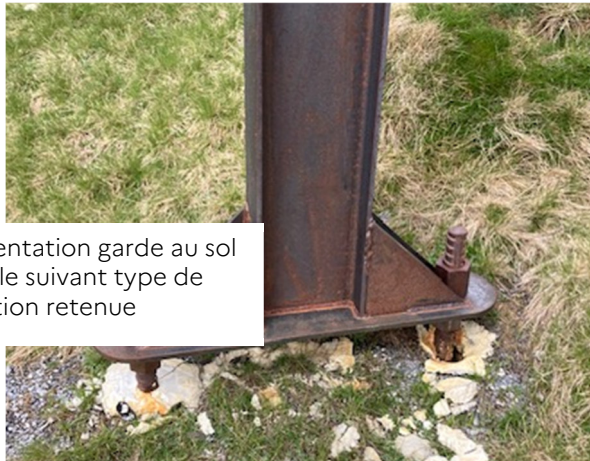
Figure 5: Exemple de barrière où le système de fondation réhausse la garde au sol de plusieurs centimètres (La Pierre Saint Martin – Dispositif NGE réalisé en 2023 – RTM).
