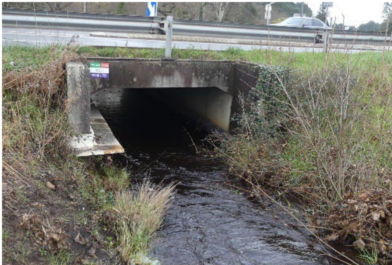
Banquette en encorbellement dans l'ouvrage de franchissement de la craste de Nézer sous la RN250. Source SETEC 2024.
