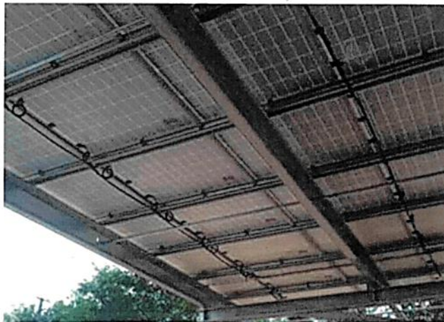
Modules avec sous face en tedlar blanc
