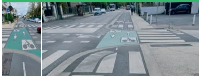
Marquages spécifiques (résines colorées ou peintures spéciales) sur chaussée pour renforcer la visibilité des franchissements cycles
