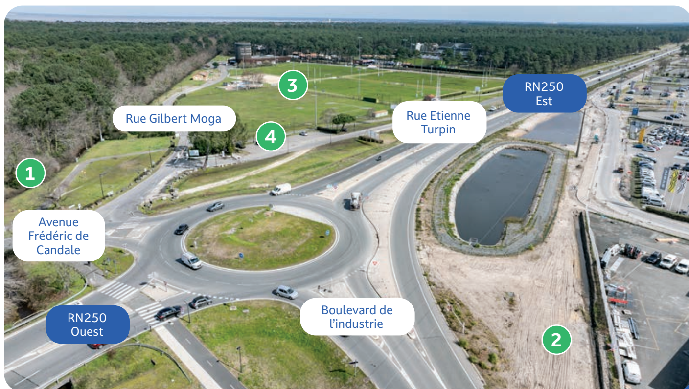
Vue sur l'aire de covoiturage existante et la plaine des sports
