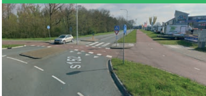
Revêtement spécifique (résines colorées) matérialisant le franchissement cycles. Signalisation verticale et horizontale indiquant la priorité aux cycles et piétons.
