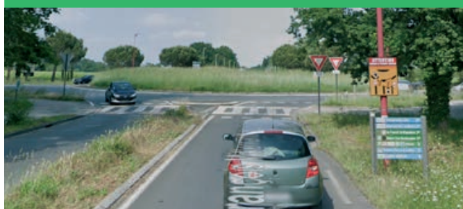
Signalisation verticale et horizontale indiquant la priorité aux cycles et piétons
