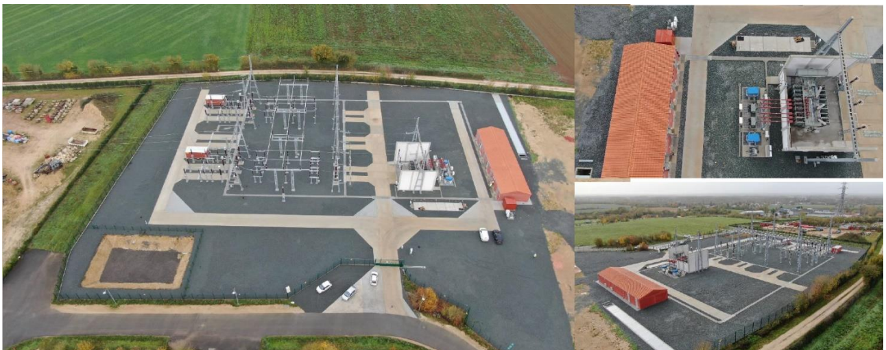
Figure 1 : Exemple d'un poste 225 000/20 000 volts (Source : GEREDIS)
