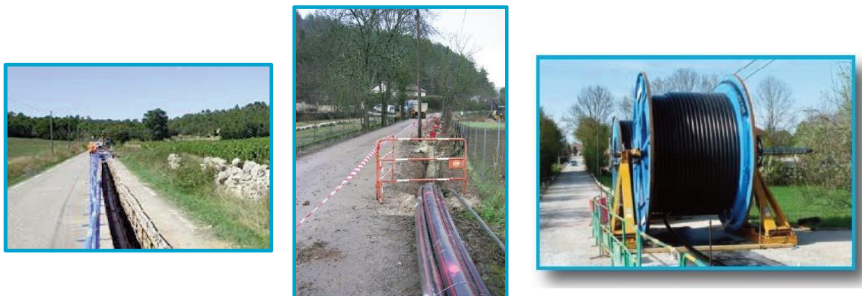
Figure 18 : Exemples d'emprises lors d'un chantier de pose de câbles électriques souterrains (Source : RTE)
