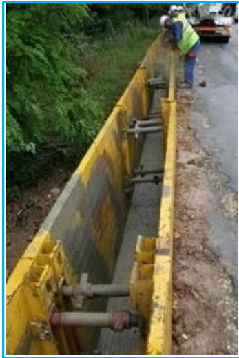
Pose en bord de chaussée
