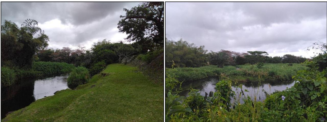
Figure 14 : Configuration des berges : profil en pente douce proche de 3H/1V
