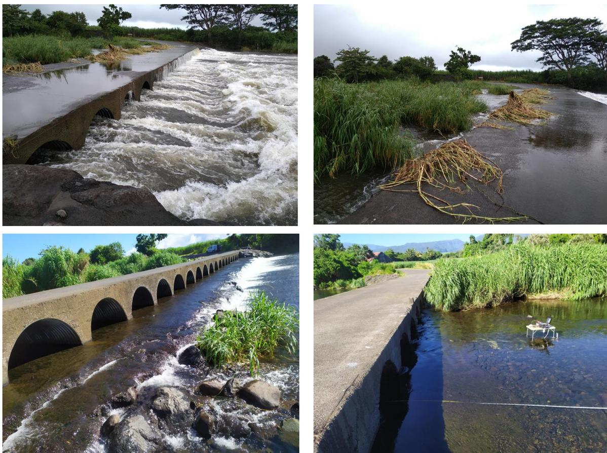
Figure 32 : Photographies de l'écoulement en amont et aval du seuil en conditions hydrologiques de hautes eaux (en haut) et de basses eaux (en bas).
