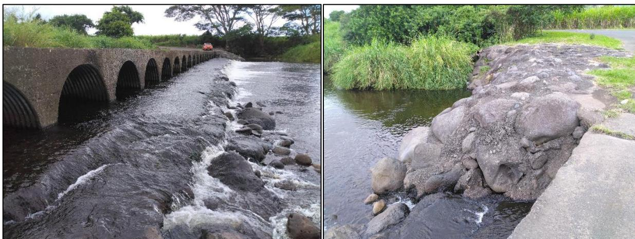
Figure 5. Ouvrage de Beauvallon à démolir comprenant le radier béton, les buses PVC ainsi que les enrochements liaisonnés servant d'ancrage au droit des berges
