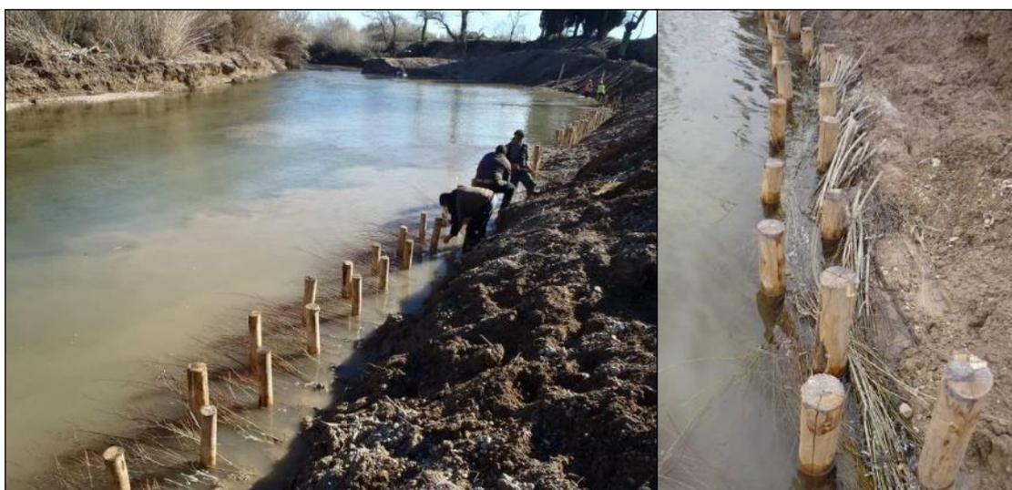
Figure 97. Exemple de réalisation d'une fascine en cours de réalisation
