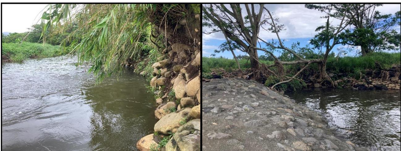
Figure 13 : illustrations des phénomènes d'érosion et d'affouillement au niveau de la berge rive gauche ainsi que de part et d'autre du radier de Beauvallon.
