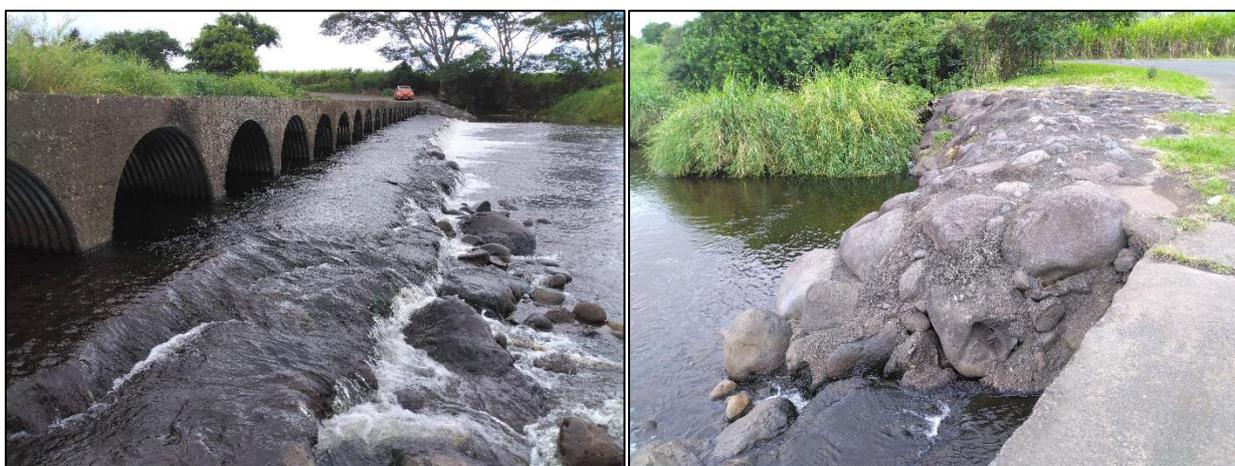
Figure 96. Ouvrage de Beuvallon à démolir comprenant le radier béton, les buses PVC ainsi que les enrochements liaisonnés servant d'ancrage au droit des berges
