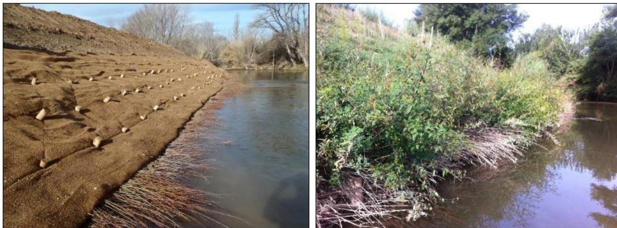
Figure 98. Exemple de réalisation d'une fascine, en fin de travaux photo de gauche et après une saison de végétation photo de droite
