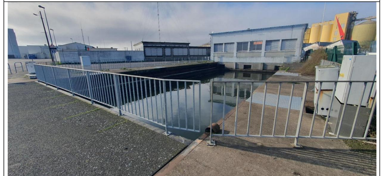
Photographie n°2 : vue (dans les sens Est vers Ouest) de l'enclave de la porte amont de la forme Joubert, enclave occupée quand la porte est en position ouverte (source : ACE<sup>3</sup>, 24/10/2024).
