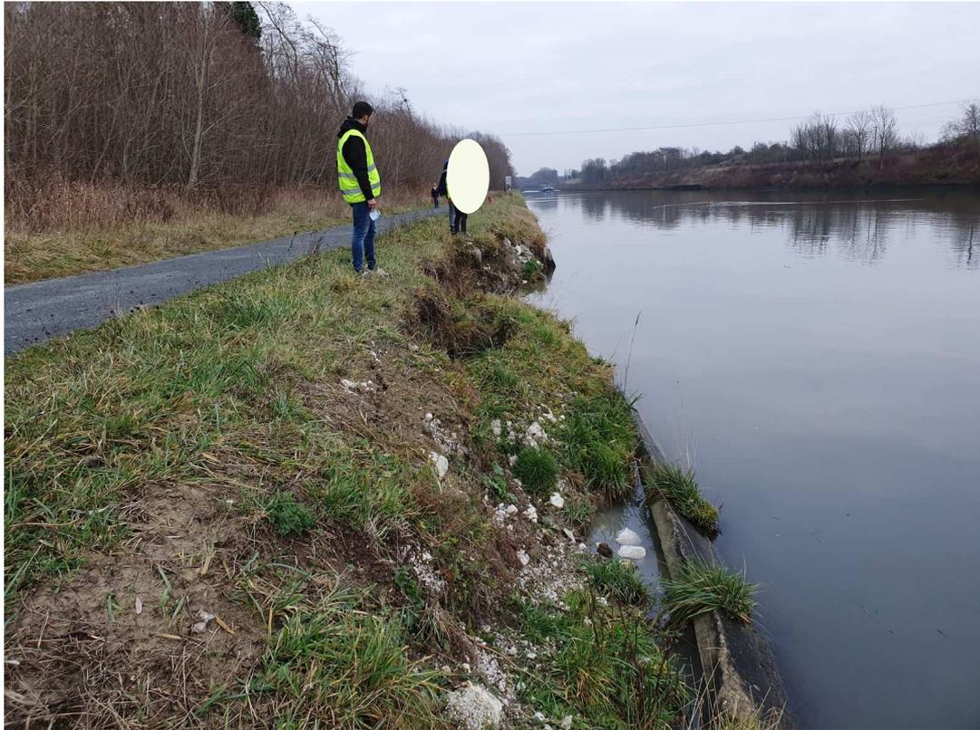
Figure 5. Photographie de la berge rive droite à conforter pour l'implantation du garage à écluse en amont de l'écluse de Cuinchy (vue vers l'amont) – ISL, Décembre 2021
