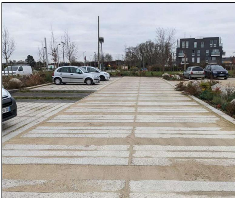
Figure 4 : Exemple de mise en place de revêtements à base de traverses en béton (Zac de Bondoufle)
