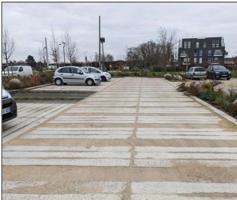
*Figure 7 : Exemple de mise en place de revêtements à base de traverses en béton (Zac de Bondoufle)*
