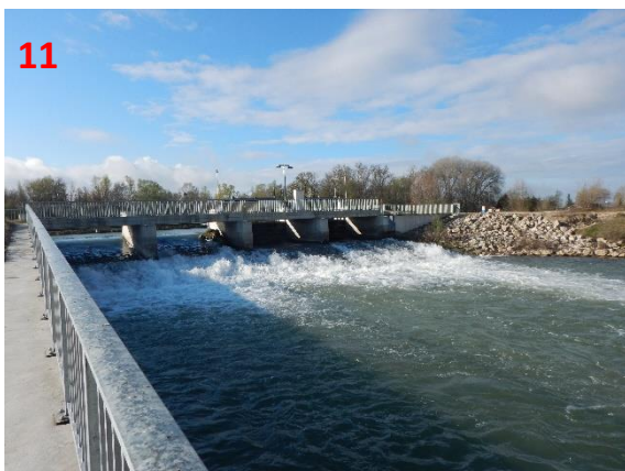
11 ORD vu depuis la rive droite en aval (Photo prise le 04/04/2019)
