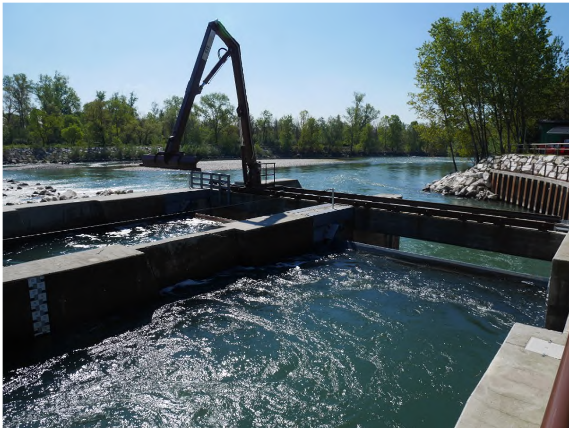
Figure 2 : Centrale VLH de Rivolta en Italie (2 turbines VLH)
