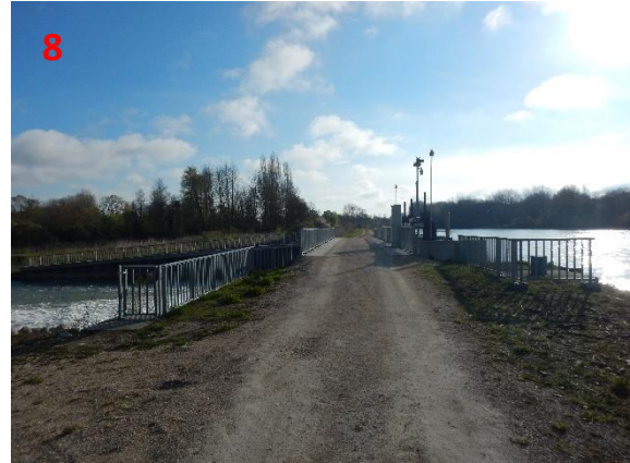
8 Chemin d'accès au-dessus de l'ORD (Photo prise le 04/04/2019)
