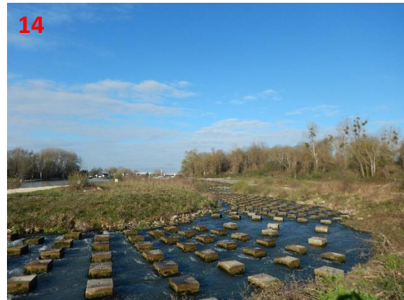
Vue de la passe à poissons depuis le rive droite (Photo prise le 04/04/2019)
