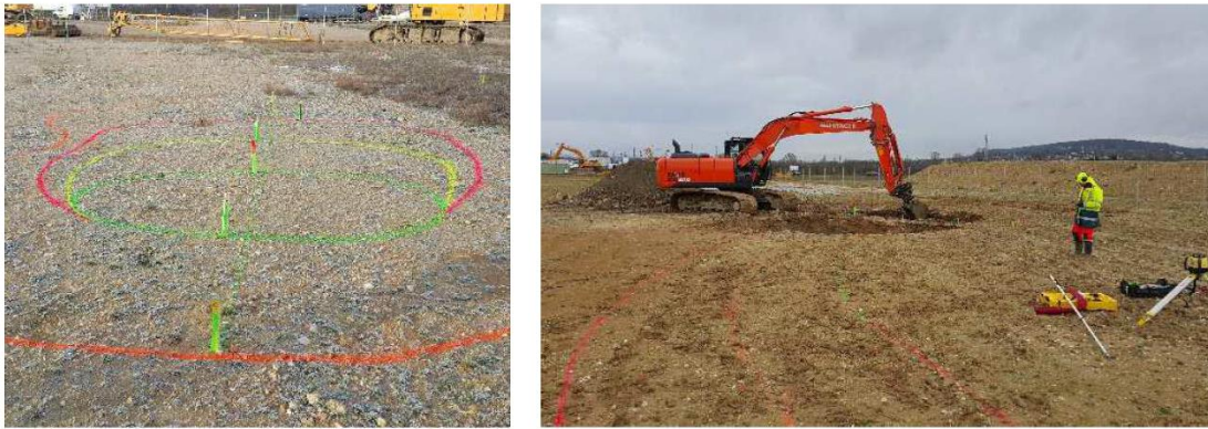
Figure 7 : Implantation et piquetage (Source : Entreprise CHARIER TP)
