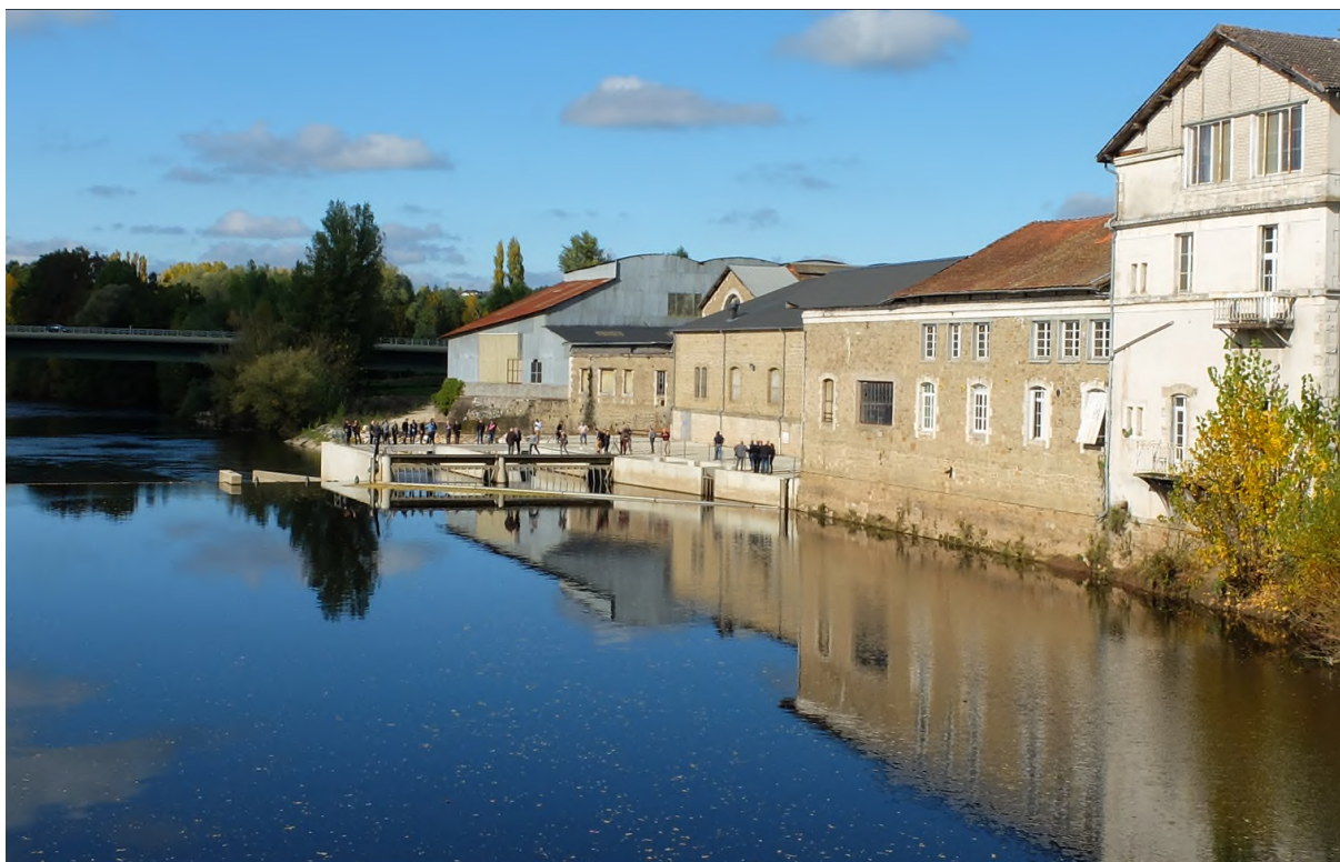
Figure 3 : Site de Larche sur la Vézère après installation des 2 turbines VLH
