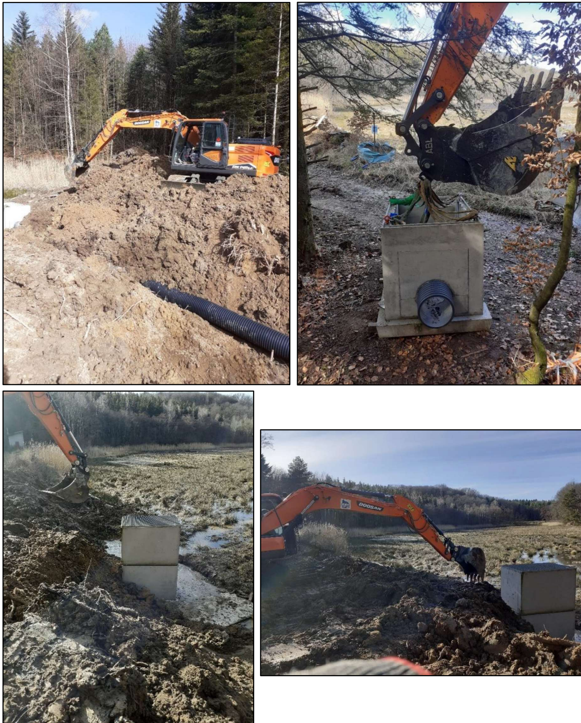
Illustration.30 : Installation des ouvrages hydrauliques.
