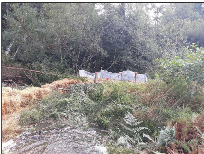
Illustration.11 : Filtre en bottes de paille et géotextile.
