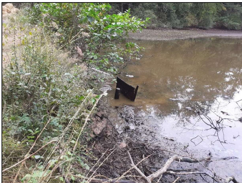
Illustration.28 : système de vidange d'origine de l'étang aval avec bonde en bois.
