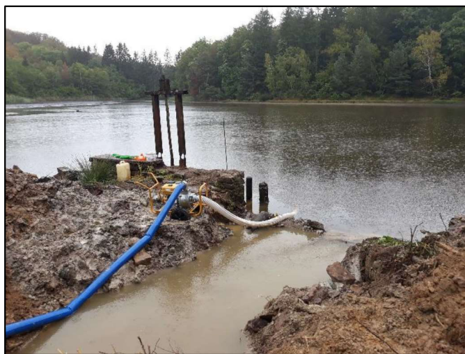
Illustration.12 : Vidange en cours avec la motopompe.
