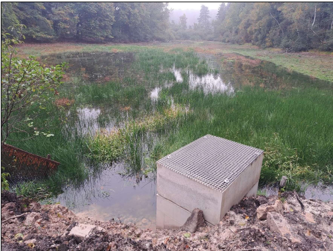
Illustration.32 : Nouveau système de vidange installé sur l'étang aval.
