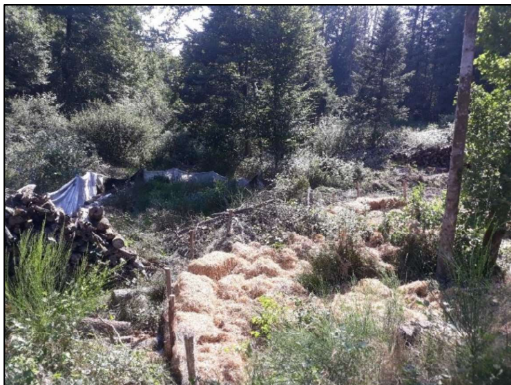
Illustrations.24 : Pose de filtres en bottes de paille et géotextile en vue de la vidange de l'étang aval.
