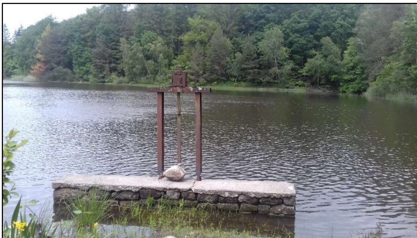
Illustration.9 : préparation des travaux hydrauliques pour le remplacement des dispositifs en place.
