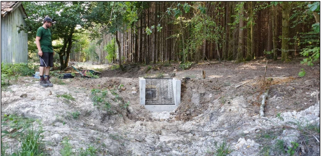
Illustration.8 : Mise en place du déversoir d'orage sur l'étang du milieu.
