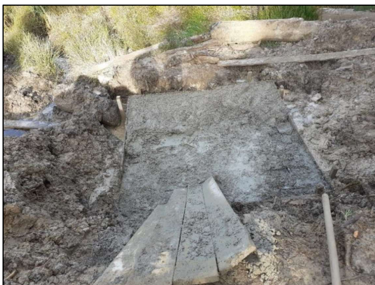
Illustration.21 : Pose d'un socle béton pour l'accueil d'un nouveau système de vidange.
