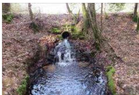
Photo 3 : Buse traversant la digue de l'étang aval, source : CENL C. Thuiller, 2014.
