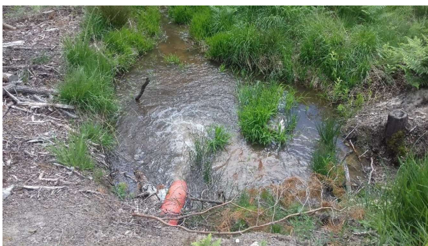
Illustration.10 : Evacuation du trop plein de l'étang du milieu
