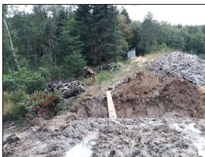
Illustrations.6 : Vue de la digue après travaux de coupe des arbres pendant les travaux hydrauliques (gauche) et retalutée (droite).
