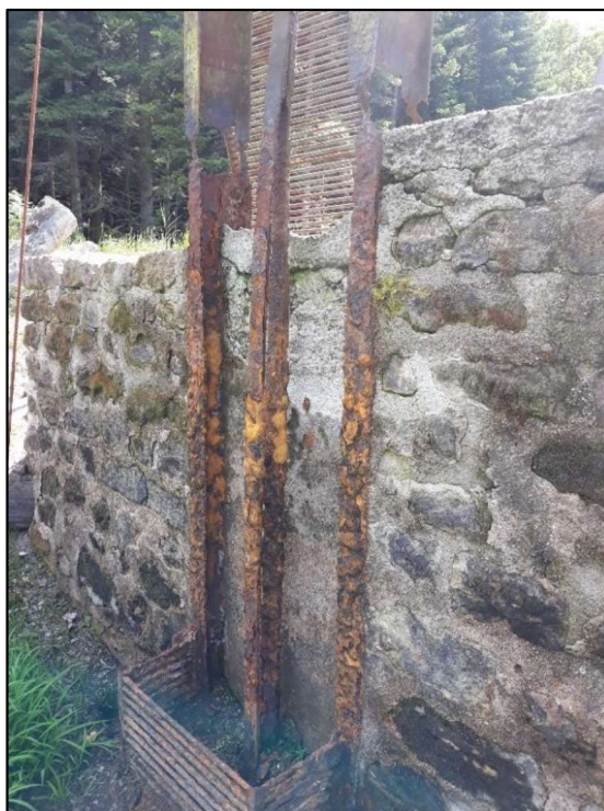
Illustration.22 : Ancien système de vidange de l'étang du milieu, vétuste, non fonctionnel et non réglementaire.
