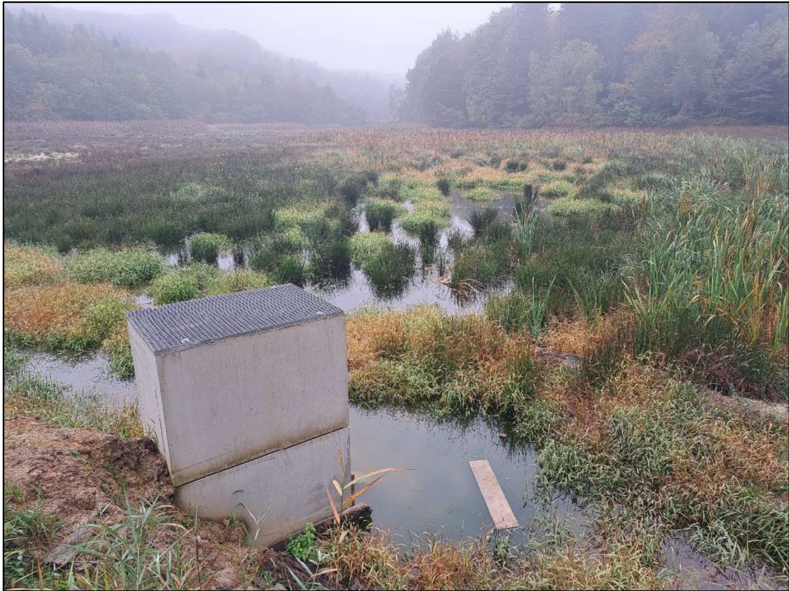
Illustration.31 : Nouveau système de vidange installé sur l'étang du milieu.
