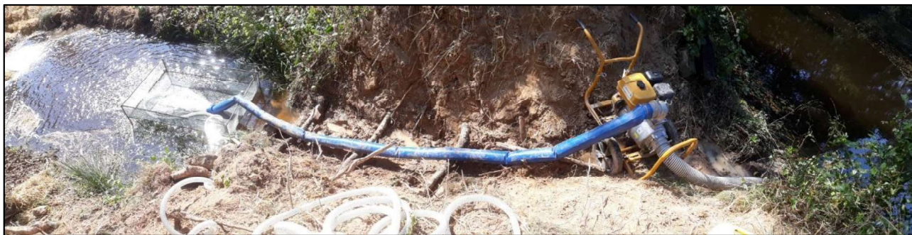
Illustration.26 : vidange de l'étang aval à l'aide d'une motopompe avec filtre pour éviter le transfert d'EEE et réduire les matières en suspension.
