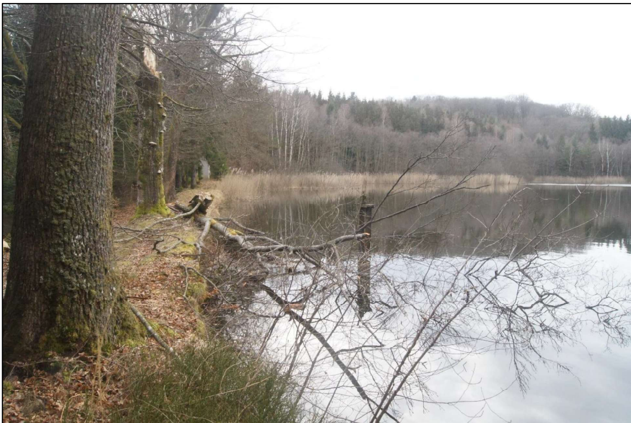
Illustration.5 : Vue de la digue avant travaux.
