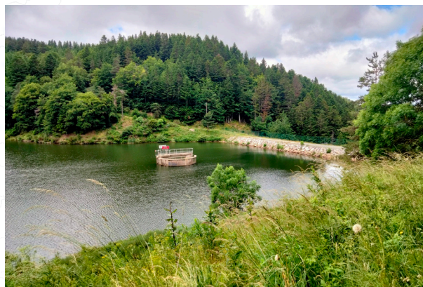
Prise d'eau circulaire permettant la vidange de la retenue d'eau // © Fabriques
