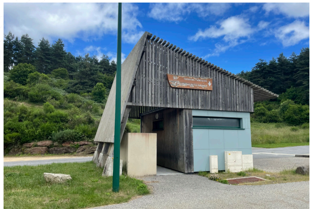
Aire de camping-car // © Fabriques
