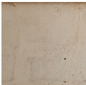
Béton de site
