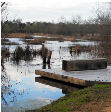
Aménagements de pontons en bois
