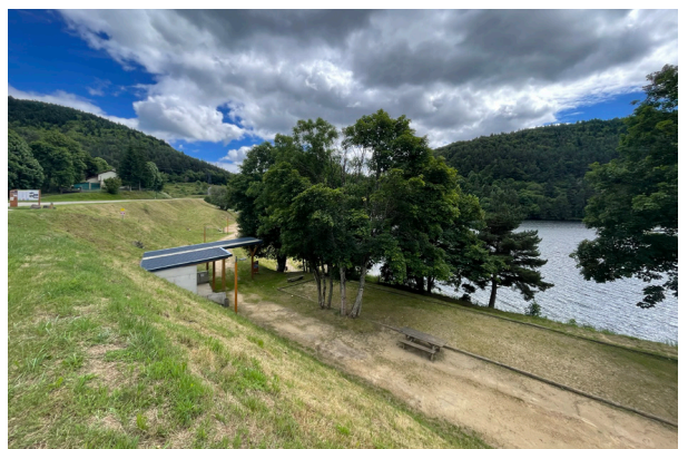
Plage équipée en contre-bas de la route départementale D160 // © Fabriques
