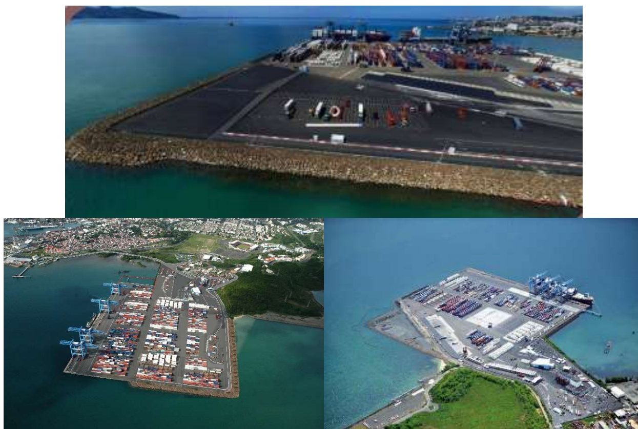
Figure 13 : Photographies de l'extension Sud-Est créée en 2017
