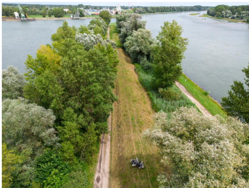
Figure 123 : Gestion des lisières sur la digue du Rhin au sein de la ZAC assuré par les Eco-pattes – crédits photographies : Eco-pattes
