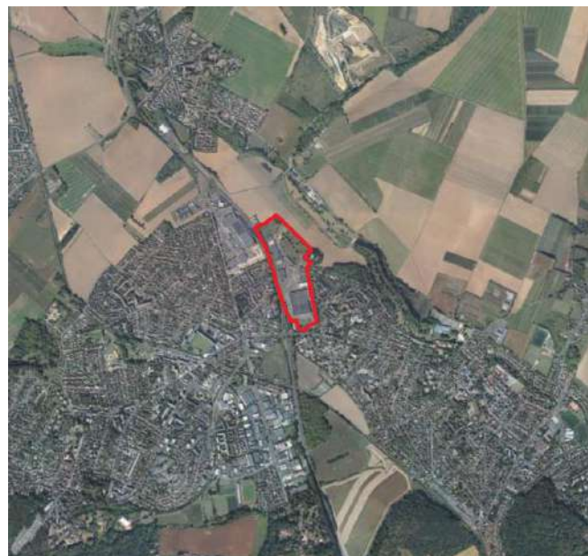
Figure 2: Vue aérienne actuelle (source : remonterletemps.ign.fr)
