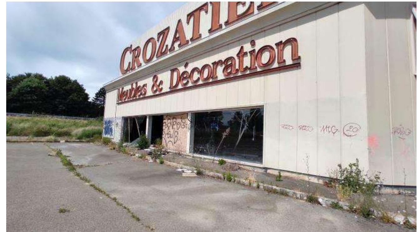
Val d'Ezanville au niveau de l'ancien Crozatier (MEDIATERRE Conseil)
