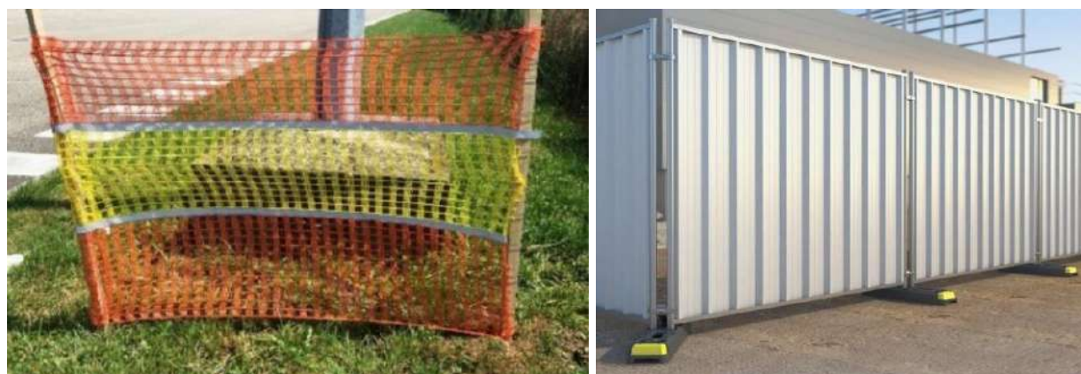
Filet de balisage temporaire et palissade de chantier (Cap Terre)
