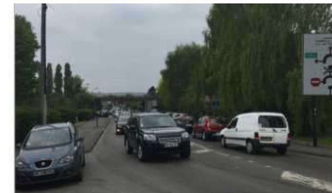
Saturation de la RD370 entre les giratoires d'accès à la zone commerciale et le diffuseur RD370/RD301 (CDVia)
