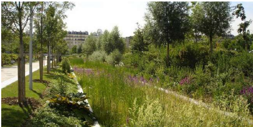
EXEMPLE DE NOUE VEGETALISEE (CITEVERTE.COM)
