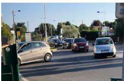
Remontées de files sur la RD370 Est et sur la RD11 à l'approche du giratoire le vendredi soir (CD Via)
