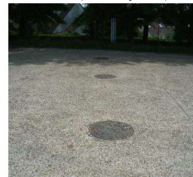
Tuyaux d'aération avant la zone de livraison et regards alignés sur dalle de béton (Atelier d'Ecologie Urbaine)
