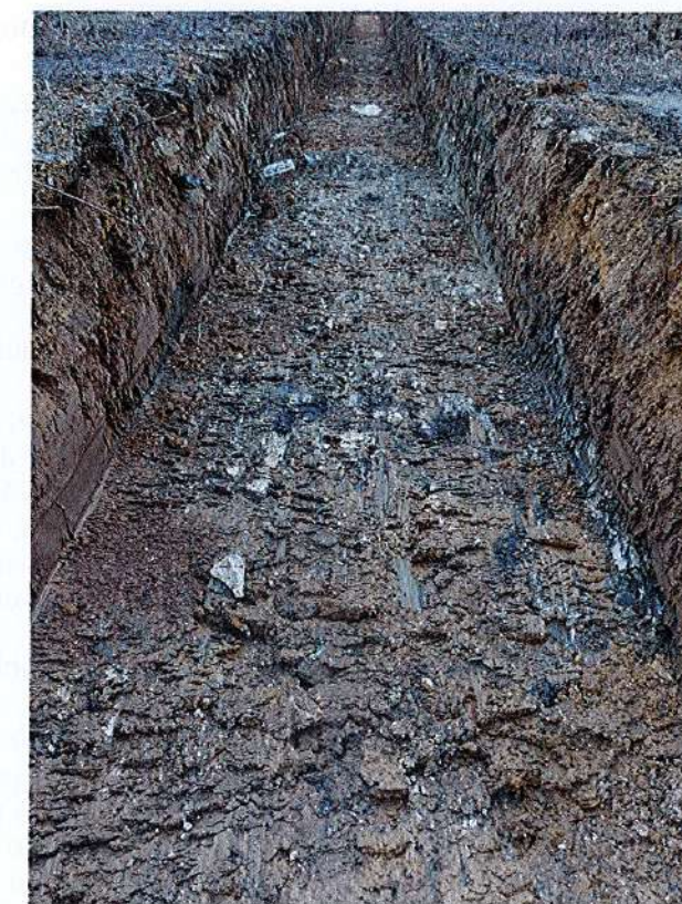
Fig. 29 Tranchée 2, vue de détail. Photo : A.-G. de Kepper, Inrap
