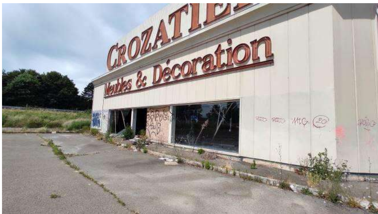
Val d'Ezanville au niveau de l'ancien Crozatier (MEDIATERRE Conseil)
