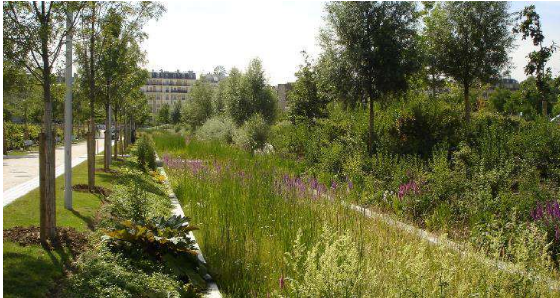
Exemple de noue végétalisée (Cap Terre)
