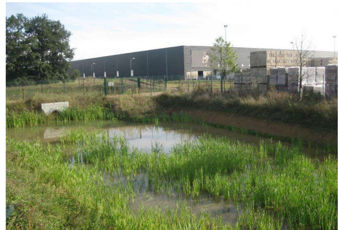
Exemple de bassin de rétention (Cap Terre)
