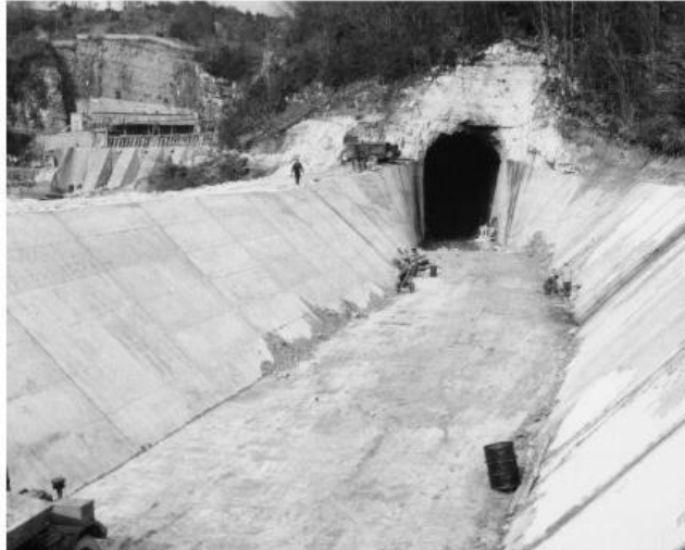
Figure 28 : Vue de l'ancien chenal en béton lors de sa réalisation
