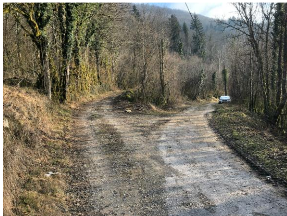
Figure 20 : Accès privé à la ferme de Vallière (piste de gauche)
