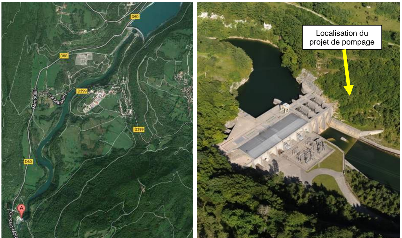
Figure 4 : Plan de localisation du barrage de Saut-Mortier (à gauche) et vue aérienne du barrage de Saut-Mortier (à droite)
