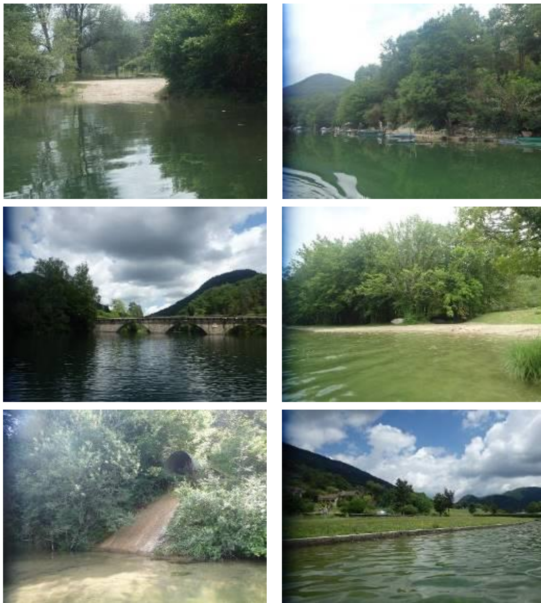
Figure 118 : Photographie des altérations rencontrées (1) Mise à l'eau, (2) Jetée-ponton, (3) Pont, (4) Apport de sable, (5) Afférence modifiée, (6) Port
