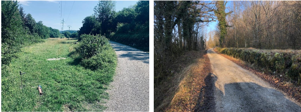
Figure 16 : Piste communale existante à élargir (à gauche) et vue des murs de soutènement amont (à droite)
