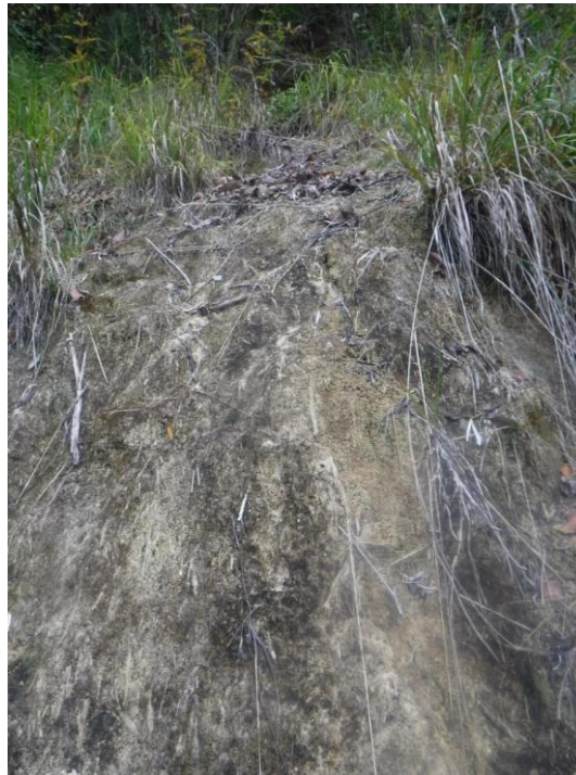
Figure 240 : Tuf identifié sur site
