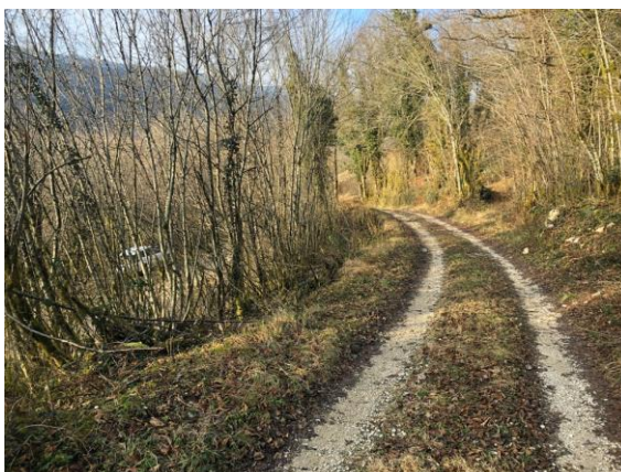
Figure 22 : Piste actuelle d'accès au village de Chancia (à terrasser)
