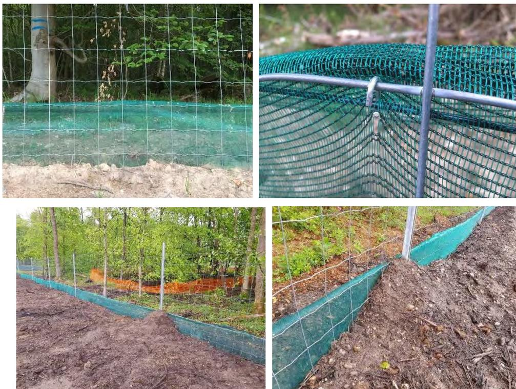
Figure 23. Exemple de dispositif anti-intrusion et semi-perméable - ©Biotope
