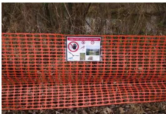
Figure 22 : Différents types de balisages de zones sensibles en bordure des emprises à mettre en place avant les travaux. © Biotope
