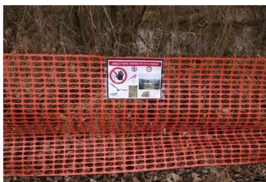
**Figure 105 : Différents types de balisages de zones sensibles en bordure des emprises à mettre en place avant les travaux. © Biotope**
