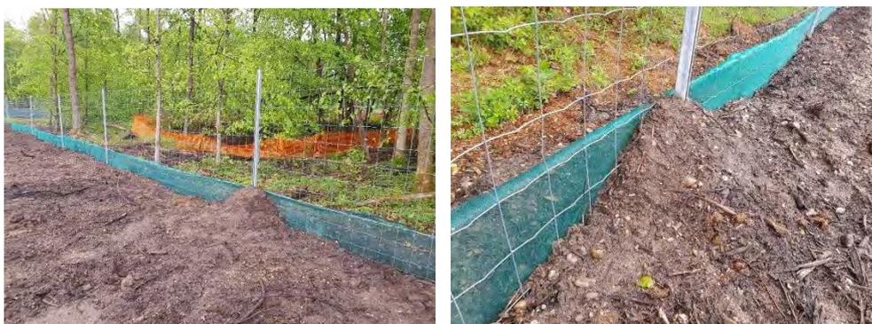
Figure 106. Exemple de dispositif anti-intrusion et semi-perméable - ©Biotope
