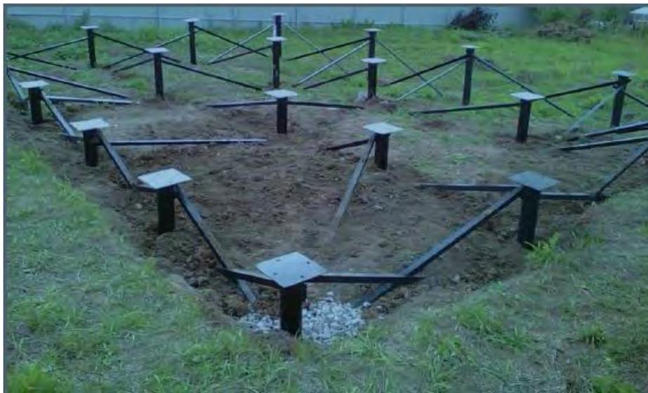
Figure 13 : Montage des modules sur pieux vissés (source : SPL Martinique Energies Nouvelles)
