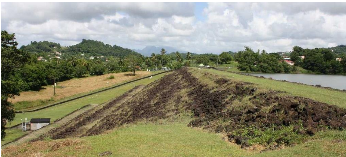
Figure 15 : Barrage de Saint Pierre Manzo : 972 – Martinique
