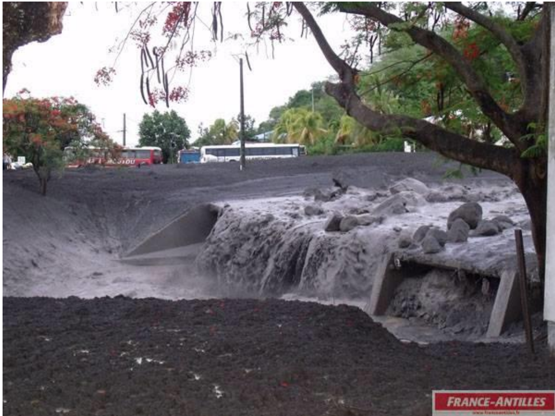
Figure 33 : Photo France-Antilles Martinique du 19 juin 2010 – Pont du Prêcheur submergé par le lahar
