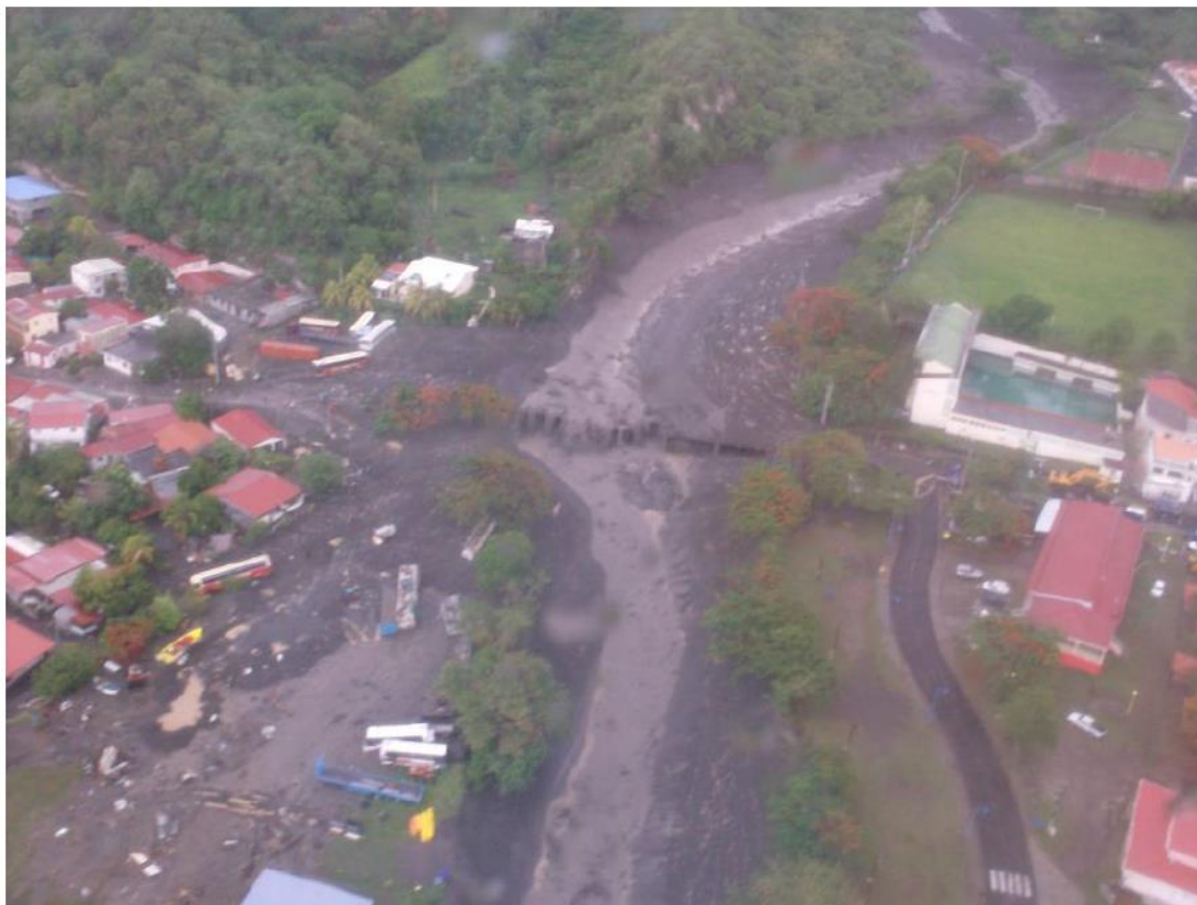
Figure 32 : Vue aérienne du lahar du Prêcheur du 20/06/2010, la lave torrentielle submerge le pont du Prêcheur
