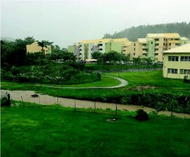
Quartier Desfarges, la pluie intense a augmenté considérablement le niveau de la rivière Pilote.
