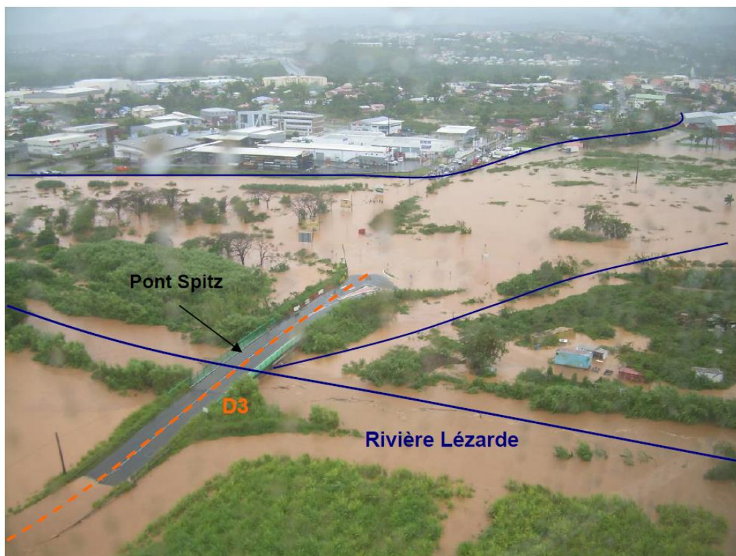
Figure 29 : Pont Spitz, au Lamentin, lors des inondations de mai 2009.
