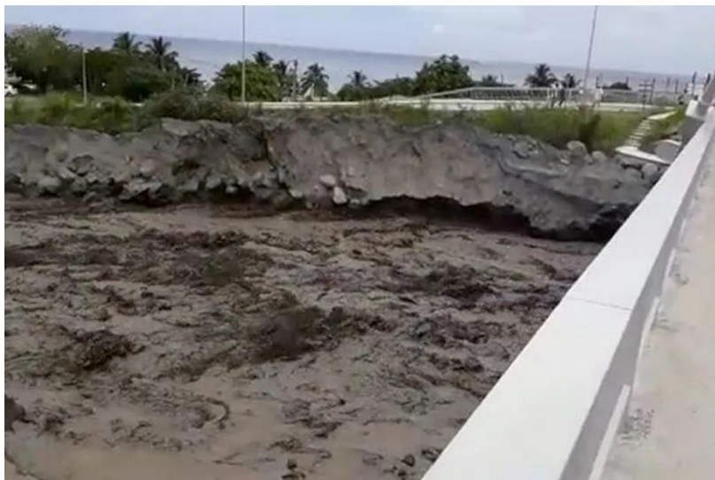
Figure 12: Sous l'effet des fortes pluies des coulées de boue se déversent dans la rivière du Prêcheur. Les activités de curage sont arrêtées compte-tenu de l'activité dans le lit de la rivière du Prêcheur • ©Diappa - 11 mai 2018
