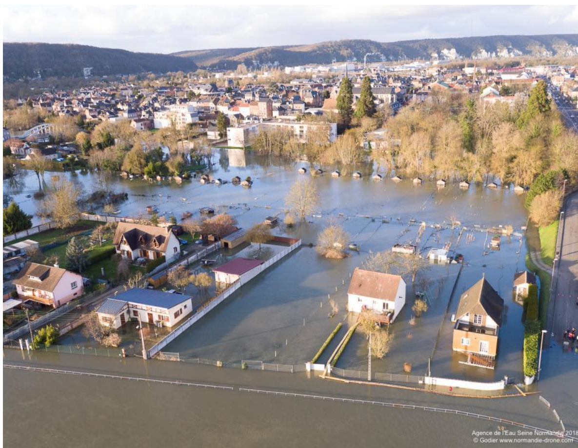
Figure 28 Crue de janvier 2018 - Elbeuf (76) - Source AESN
