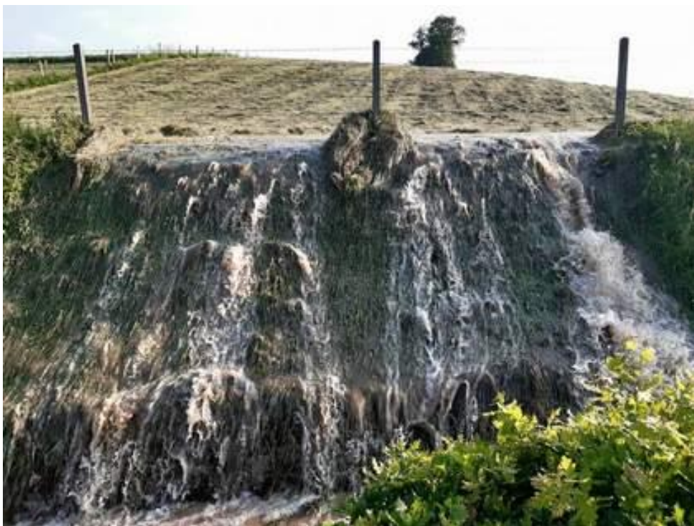
Figure 117 Orages juin 2021 - La Vaupalière (76) - Source Commune
