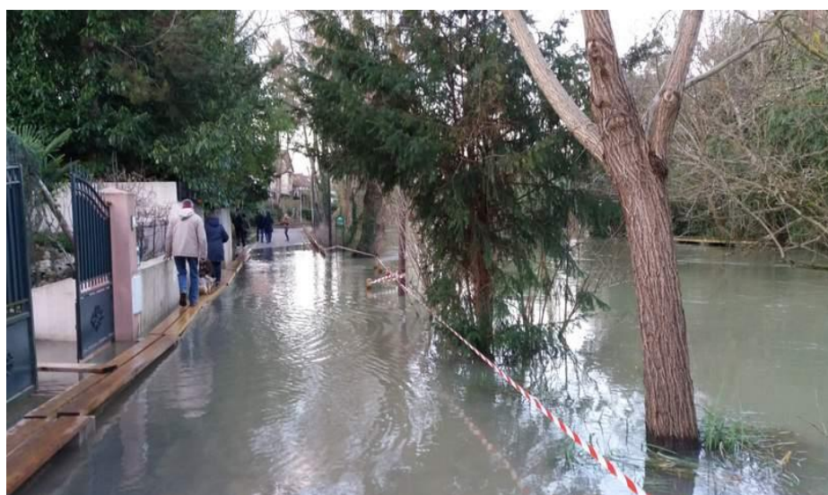
Figure 106 Créteil – crue de janvier 2018 - Source DRIEAT
