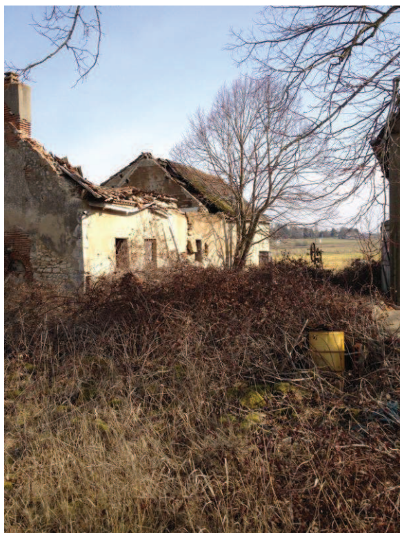
Photo n°67 : vue sur les ruines de la Ferme des Pâturaux
