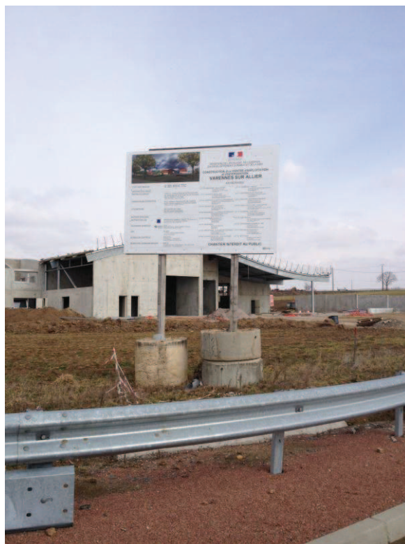
Photo n°113 : vue sur le centre d'exploitation et d'intervention de la Dir Centre Est en construction
