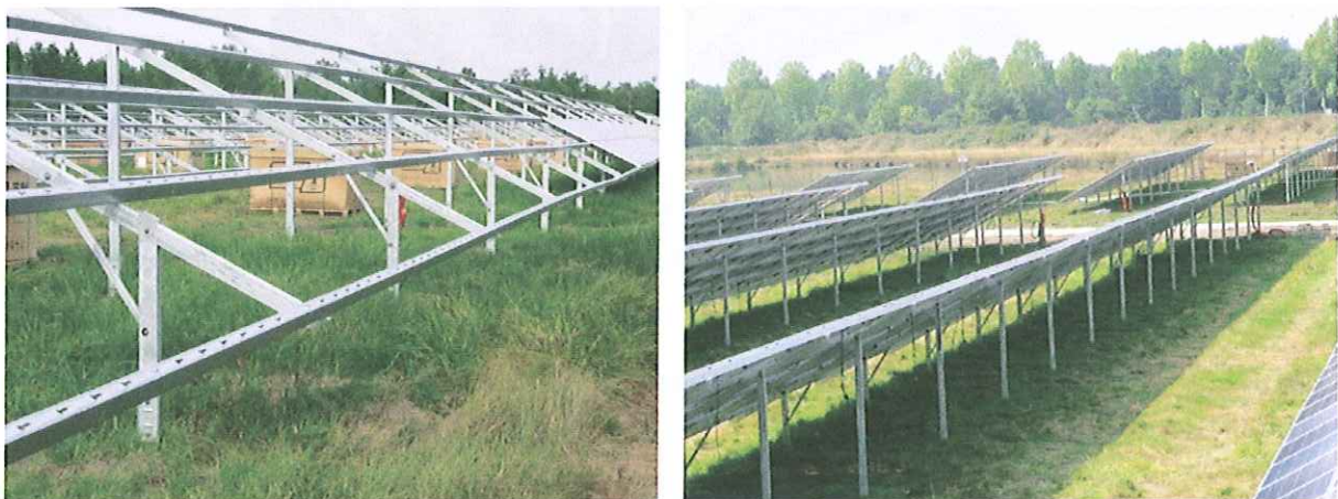
Etat du terrain suite à la pose des structures et modules (source : Luxel)
