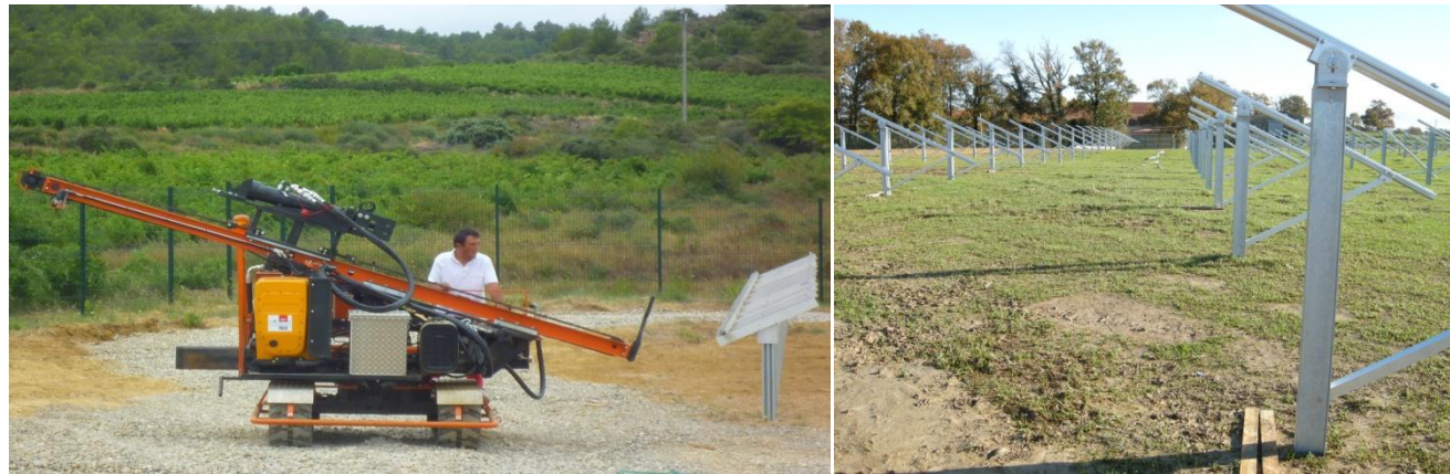
Machine de battage de pieux
