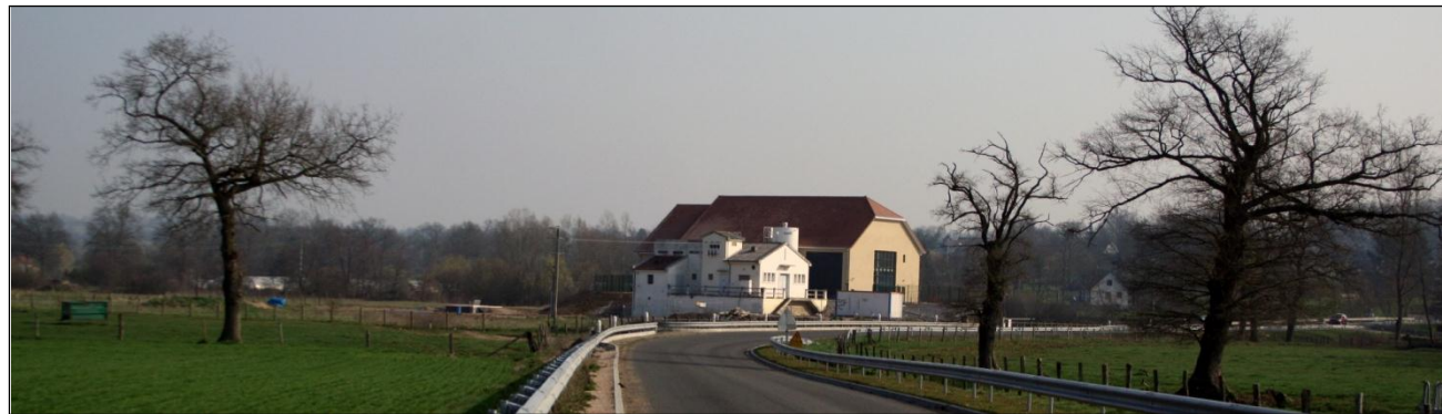
Nouvelle station de pompage vue depuis la D 423 en direction de Moulin Marin (Abies – avril 2013)
