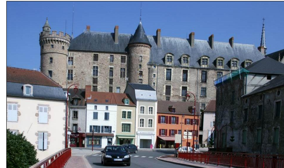
Le château avec ses maisons médiévales rénovées (Abies-avril 2013)
