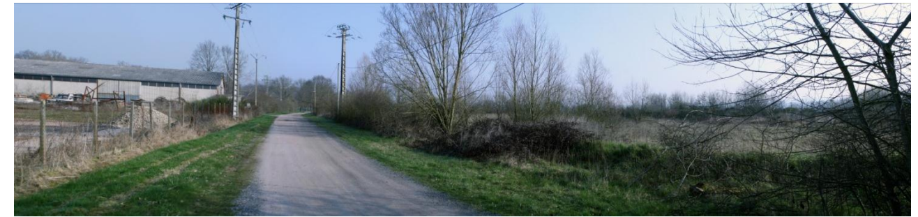
4 – Vue à droite de la voie sur la partie nord enrichie du secteur B en direction de la station d'épuration
