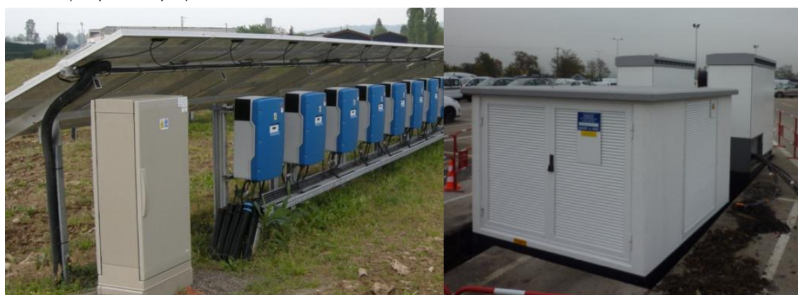
Onduleur String - Onduleur centralisé (Source : LUXEL, 2010)
