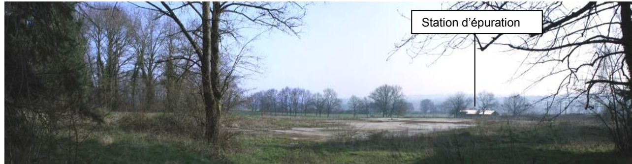
1 – Vue d'ensemble du secteur A depuis l'accès aménagé sur la RD 480
