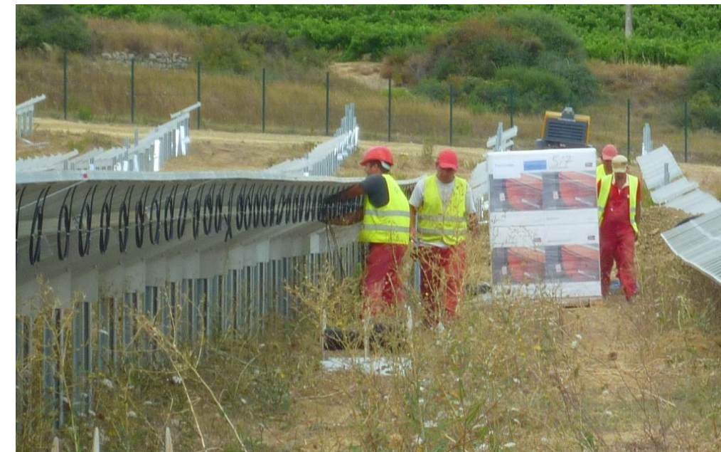
Câblage et interconnexion des modules photovoltaïques – (Source : Luxel, 2010)
