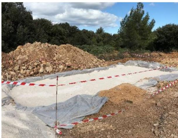
Figure 38 : Fouille préparée pour la pose d'un poste de conversion/transformation (Source : EDF Renouvelables)
