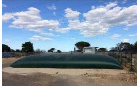
Figure 30 : Exemple d'une citerne souple (Source : EDF Renouvelables)
