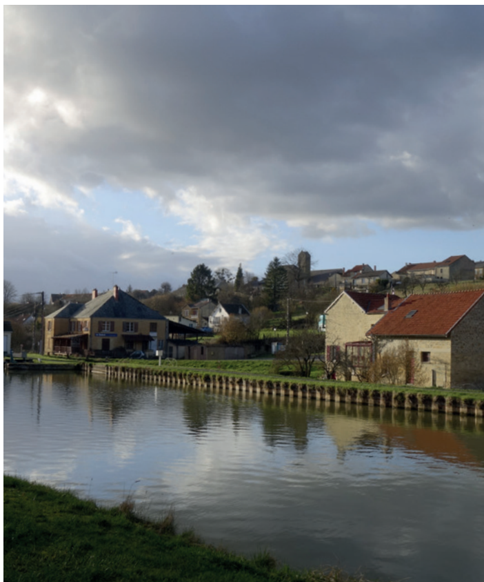
La Coquée, ancien port en contre-bas de Neuville.
