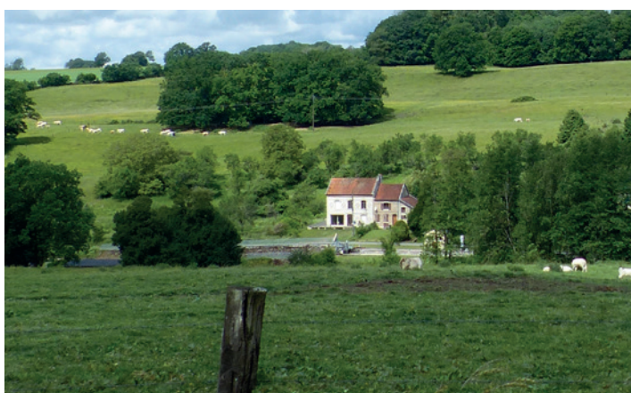
Présence discrète d'anciens établissements liés au canal à Montgon.
