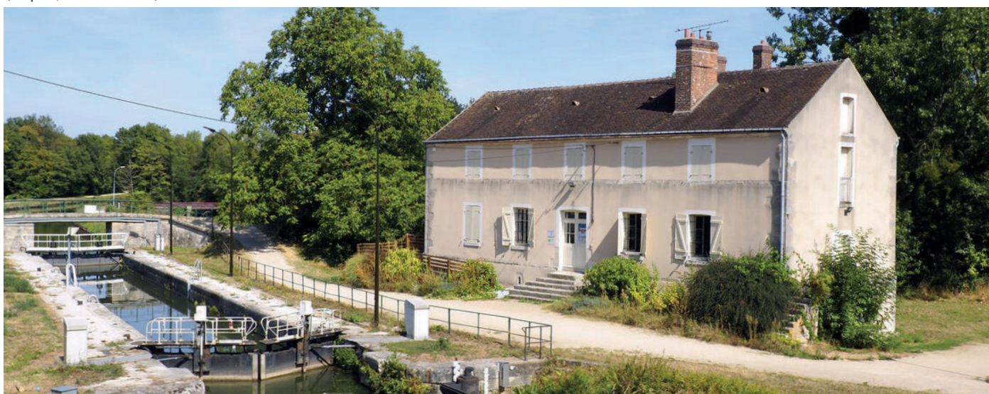
Site de l'écluse de Buges, sur le canal de Briare, premier canal à bief de partage de France. XVIIe siècle.
