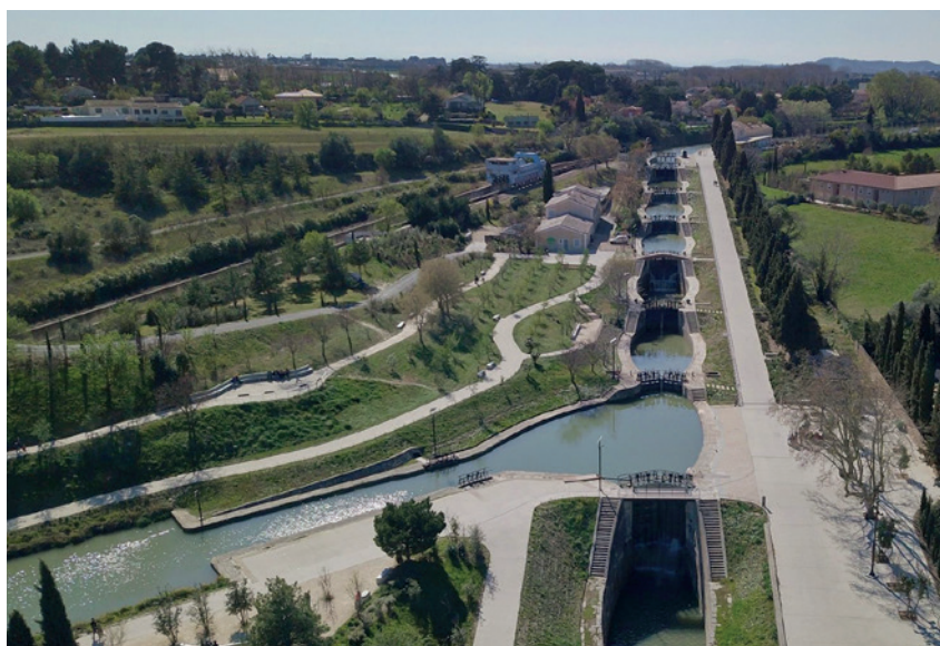
Les écluses du canal du midi, de forme concave avec porte à vantaux. XVIIe siècle.
