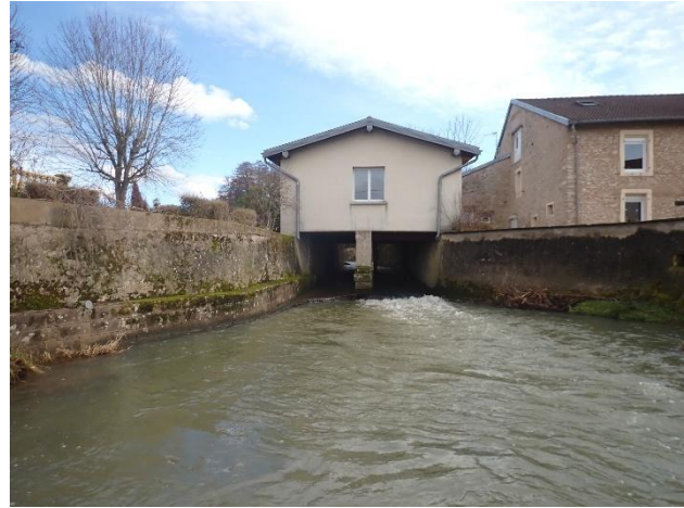
Figure 29 : Petite fosse peu profonde à l'aval immédiat du ROE 101510
