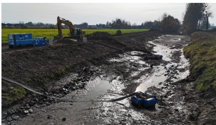
Figure 45 : Mise à sec de la zone de pêche, vue générale aval vers amont – Tinca Environnement 2026
