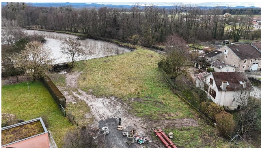
Figure 22 : Zone de terrassement du bras de contournement de l'ouvrage ROE 101510
