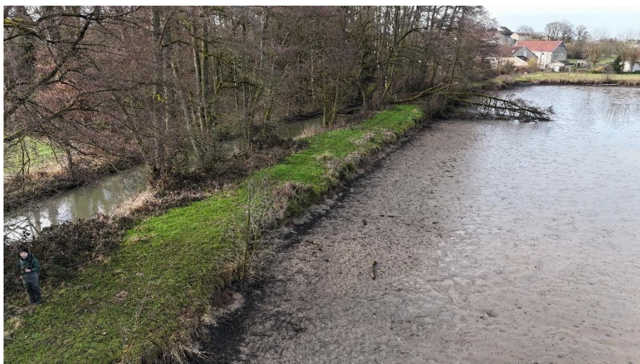
Figure 26 : Digue de l'étang Sous Launoy
