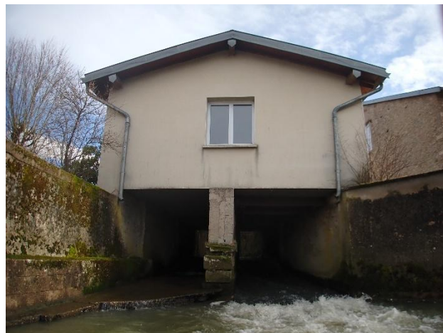
Figure 3 : ROE 101510 – Ancien moulin – Vue vers l'amont
