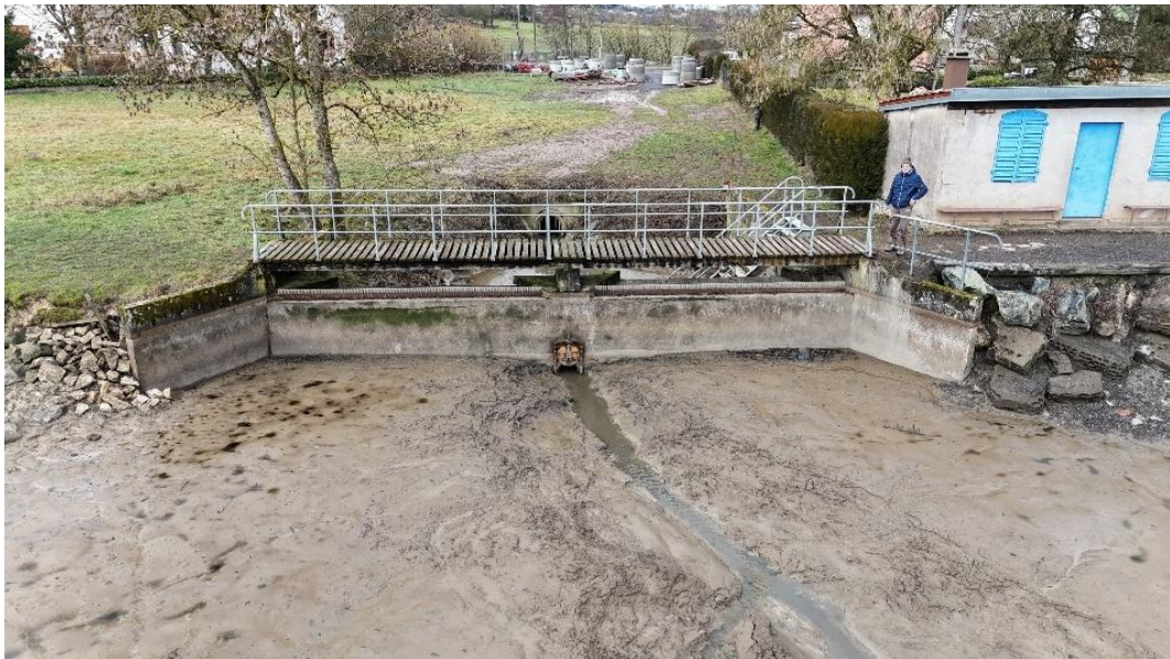
Figure 5 : Surverse et buse de vidange
