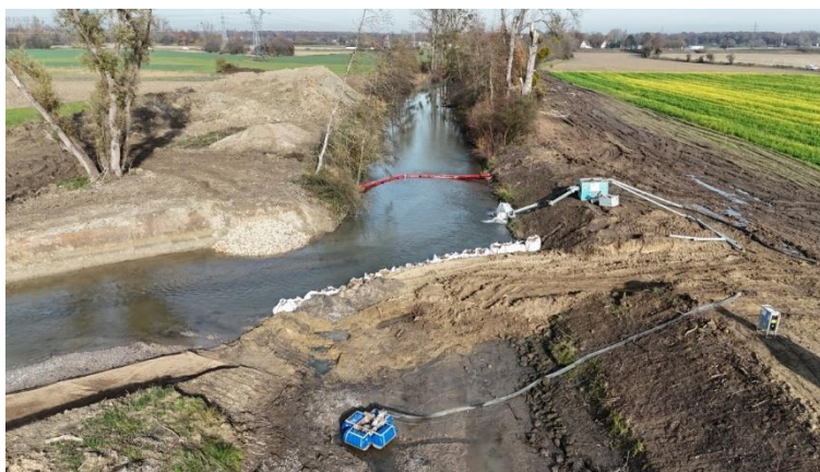
Figure 44 : Mise à sec d'une zone de pêche, vue générale amont vers aval – Tinca Environnement 2026
