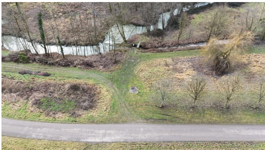
Figure 25 : Accès par la rue de la Forge à l'ouvrage ROE 101511
