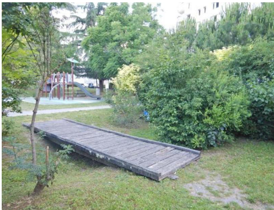
Photo 10 : Passerelle sur noue d'infiltration des eaux météoriques ©APAVE, 2022
