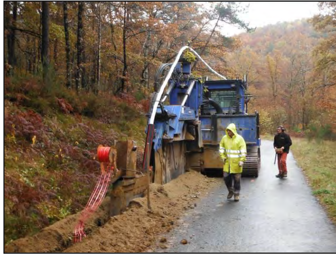
Photo de trancheuse prise sur chantier
