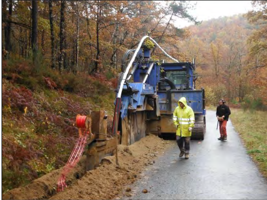
Photo de trancheuse prise sur chantier
