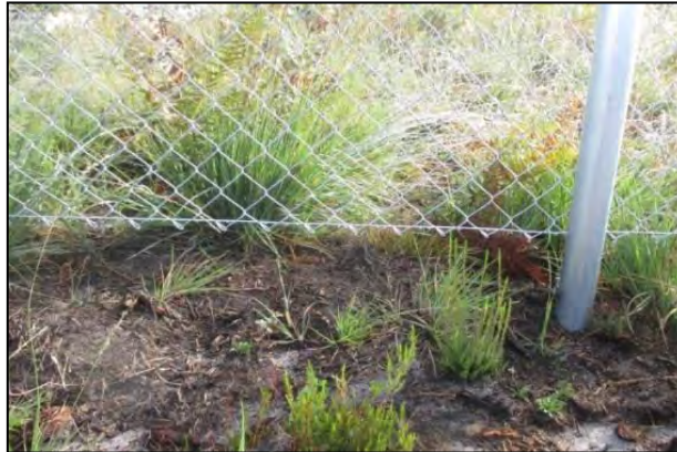
Exemple de clôture perméable © ETEN environnement
