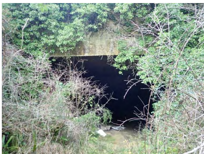
Entrée de l'ancienne carrière du « Vidaud »
