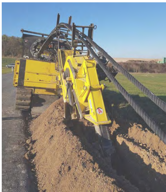
Exemple de travaux de raccordement HTA en bord de chaussée
