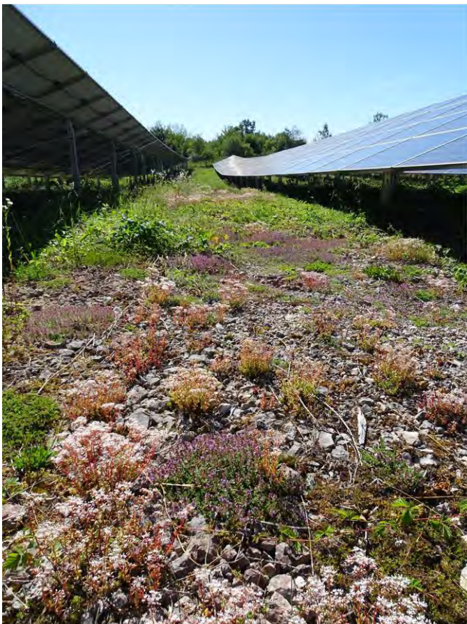
Parc photovoltaïque de Soucia (Jura) : milieu calcicole, présence du serpolet (interrangs de 4 m de large)
