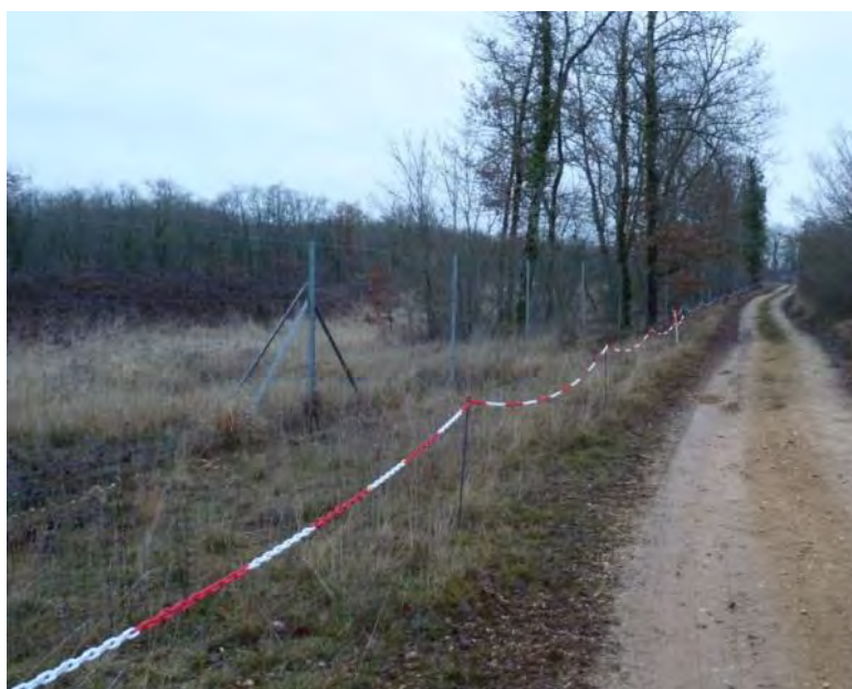
Exemple de mise en défens et de délimitation d'une piste d'accès au chantier (Ecosphère)
