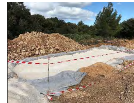
Exemple de fouille préparée pour la pose d'un poste de conversion
