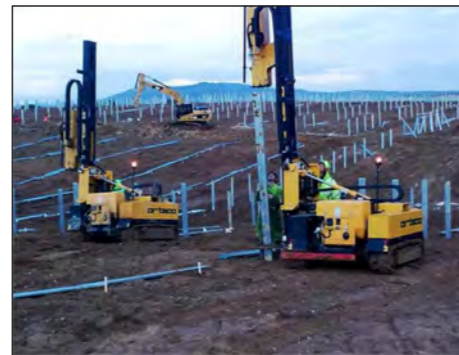
Installation des pieux battus
