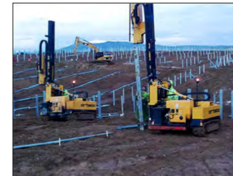
Installation des pieux battus Source : EDF Renewables
