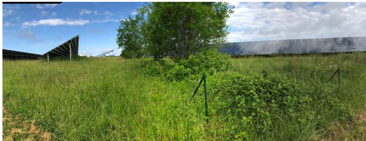
Figure 46 : Corridor écologique préservé au sein de la centrale de Bouloc Source : EDF Renouvelables
