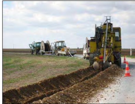
Exemple des travaux mis en œuvre pour le raccordement externe
