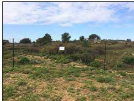
Exemple de clôture fusible
