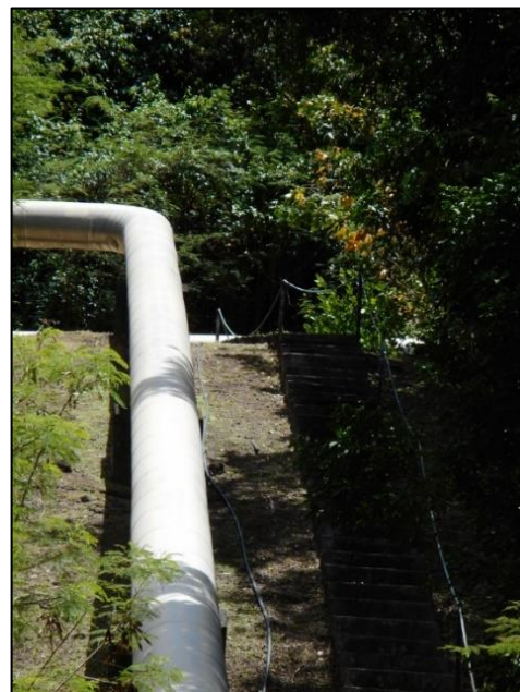
Photo 7 - Pose sur des blocs béton des futurs collecteurs
