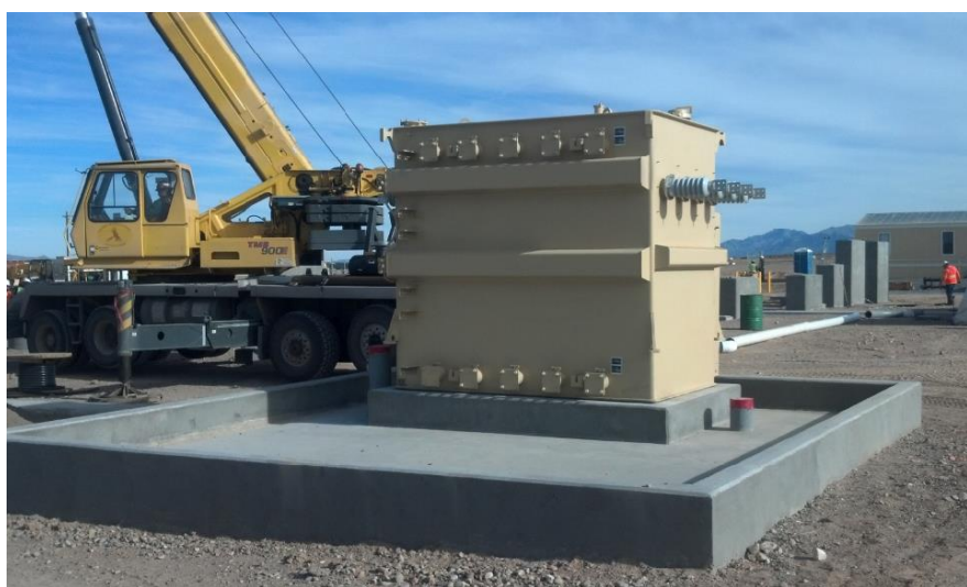
Figure 18 : Exemple de transformateur 5,5kV/20 kV qui sera installé à proximité du transformateur actuel sur la parcelle EDF contigüe au site de la centrale dans le bourg de Bouillante
