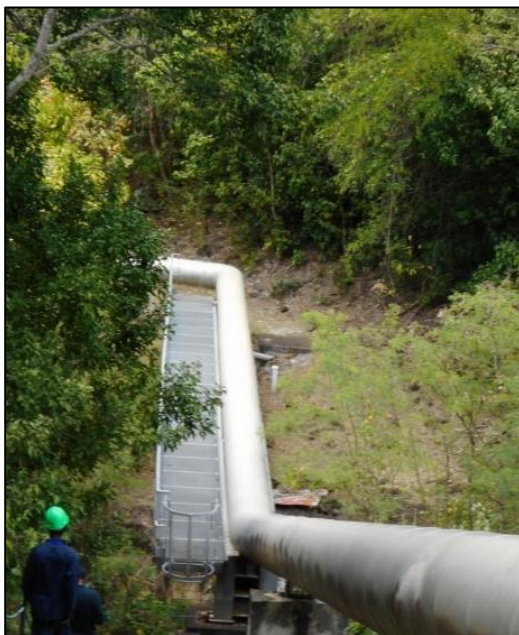
Photo 6 - Traversée aérienne de la Rivière Blanche par le pont
