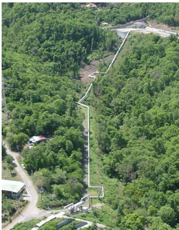
Figure 37 : Vue du trajet de la conduite de transport du fluide géothermique depuis la plateforme des puits (en haut à droite) jusqu'au séparateur haute pression (en bas), et vue rapprochée du séparateur eau/vapeur haute pression. (2020)
